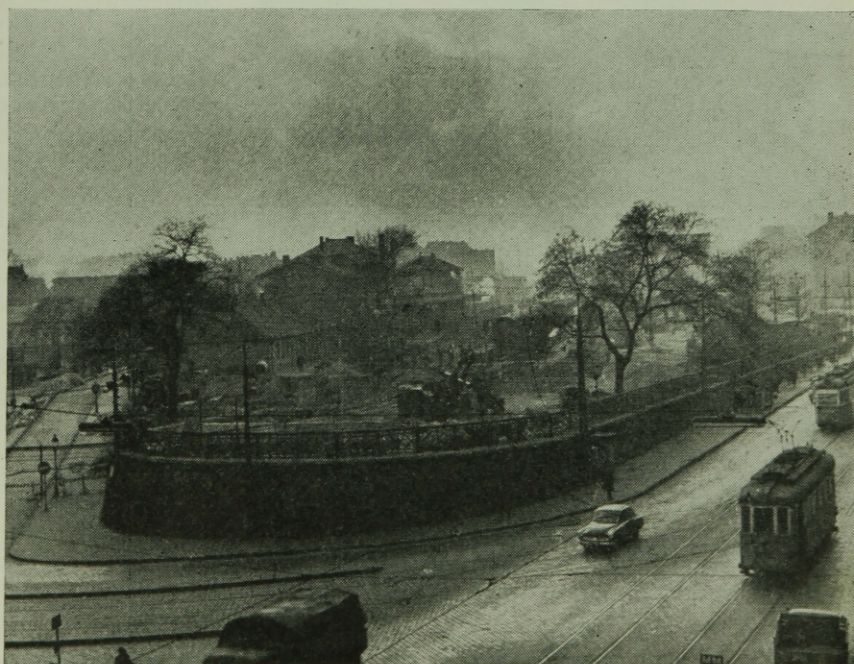
5. ábra. Déli pályaudvar építése. 1962. február. A régi patkóalakú támfal még látszik. Mögötte a fordítókörong már elbontva, a földkiemelés folyik
