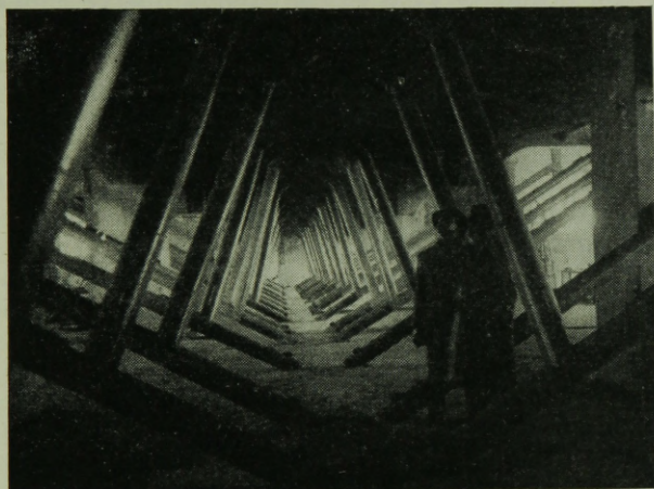
10. ábra. A 2. sz. tárház földszintje átépítés után
