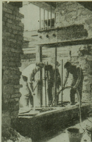
10. ábra. Vetítőgépház feletti kiváltógerenda felfüggesztése alulról nézve
