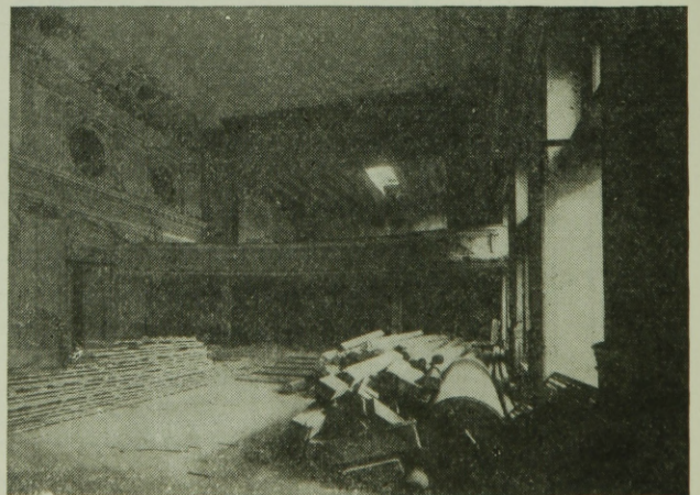
8. ábra. Az elkészült karzat feletti födém, és a megszállított karzatnyílás feletti kiváltás
