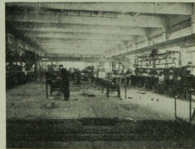
32. ábra. Előrefeszített vasbetonaljak gyártócsarnoka
