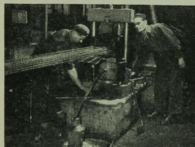
36. ábra. Huzalok összehúzója a befogófejbe
