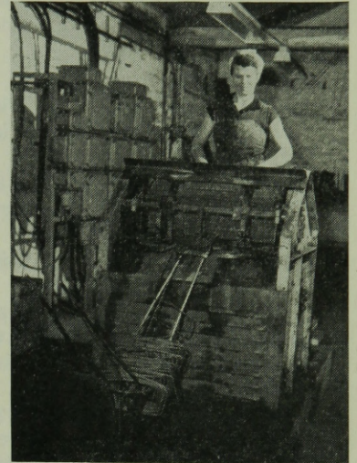
30. ábra. Kengyelhajlítógép a vasbetonaljak kengyeleinek gyártására
