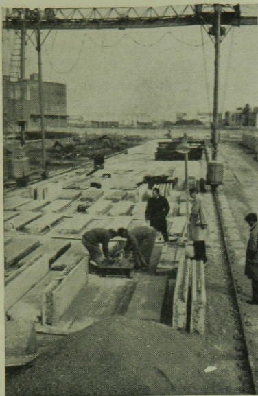
7. ábra. Dr-1 jelű épület. Falelemek gyártása
