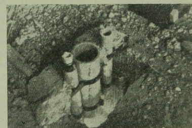
18. ábra. Födémbe betonozott bilincsekbe helyezett csőcsomók a függőleges vezetékek elhelyezésére. Később elfalazandó szerelőaknákat képezve (Bécs)
