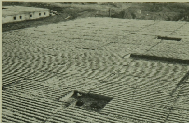
17. ábra. S-1/a—b jelű épület. Födémzsigetelő elemek elhelyezés után
