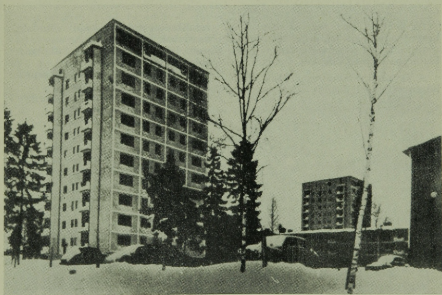
4. ábra. London — Alton Estate Roehampton ; belső teherhordó öntöttbeton falak
