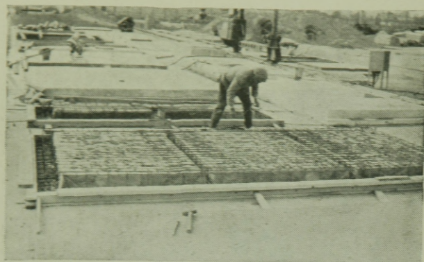
3. ábra. WPP jelű épület. Födémek zsaluzása
