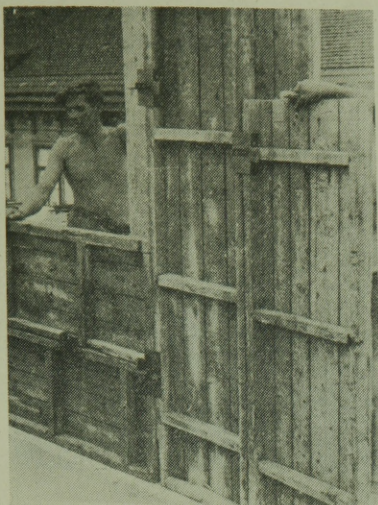
12. ábra. Új típusú osztrák zsaluzat (a BINO rendszer függőleges táblás változata) (Bécs)
