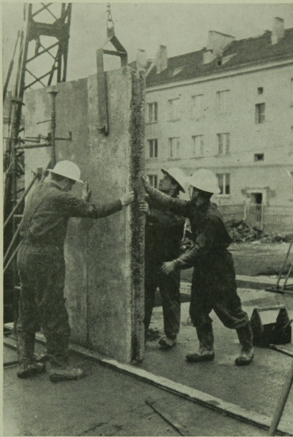
11. ábra. Dr-1 jelű épület. Könnyűbeton elemek beemelése autódaruval
