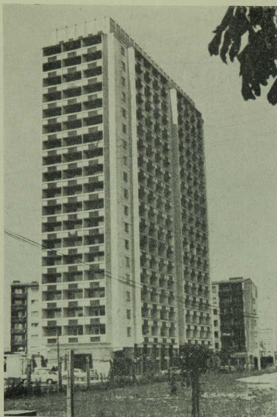
1. ábra. Linz, magasház (Lenauhochhaus); teherhordó öntött kohóhabsalakbeton falak
