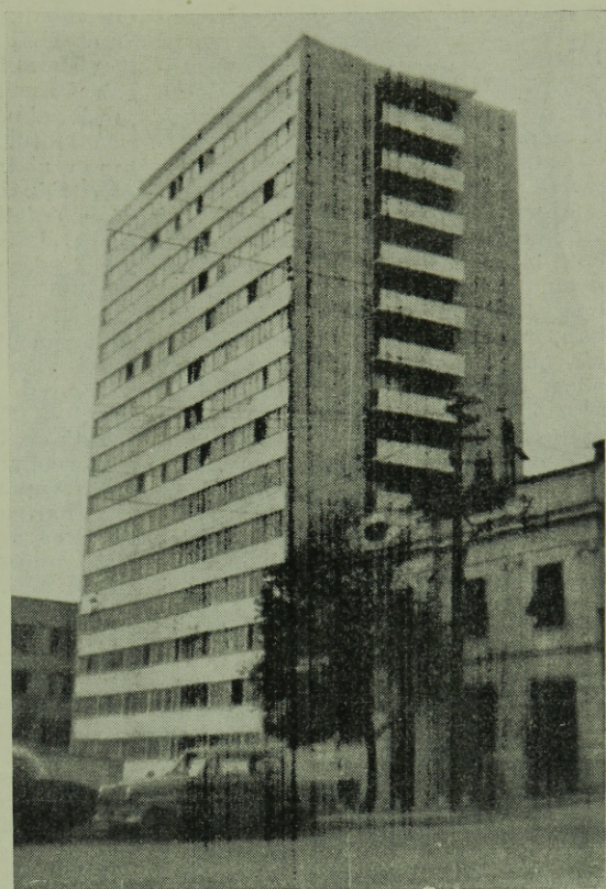
7. ábra. Belgrád ; belső teherhordó öntött kavicsbeton falak, külső előregyártott térelhatároló parapetpanelek
