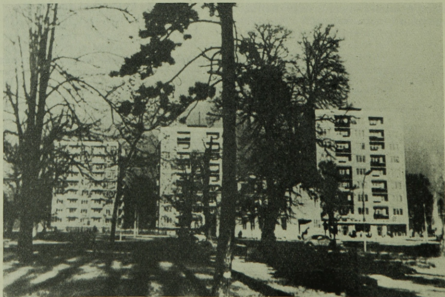
3. ábra. Gdansk, külső-belső teherhordó öntött téglatörmelékbeton falak
