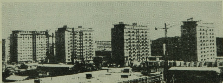
6. ábra. Bratislava ; belső teherhordó öntött kavicsbeton falak, külső előregyártott térelhatároló panelek
