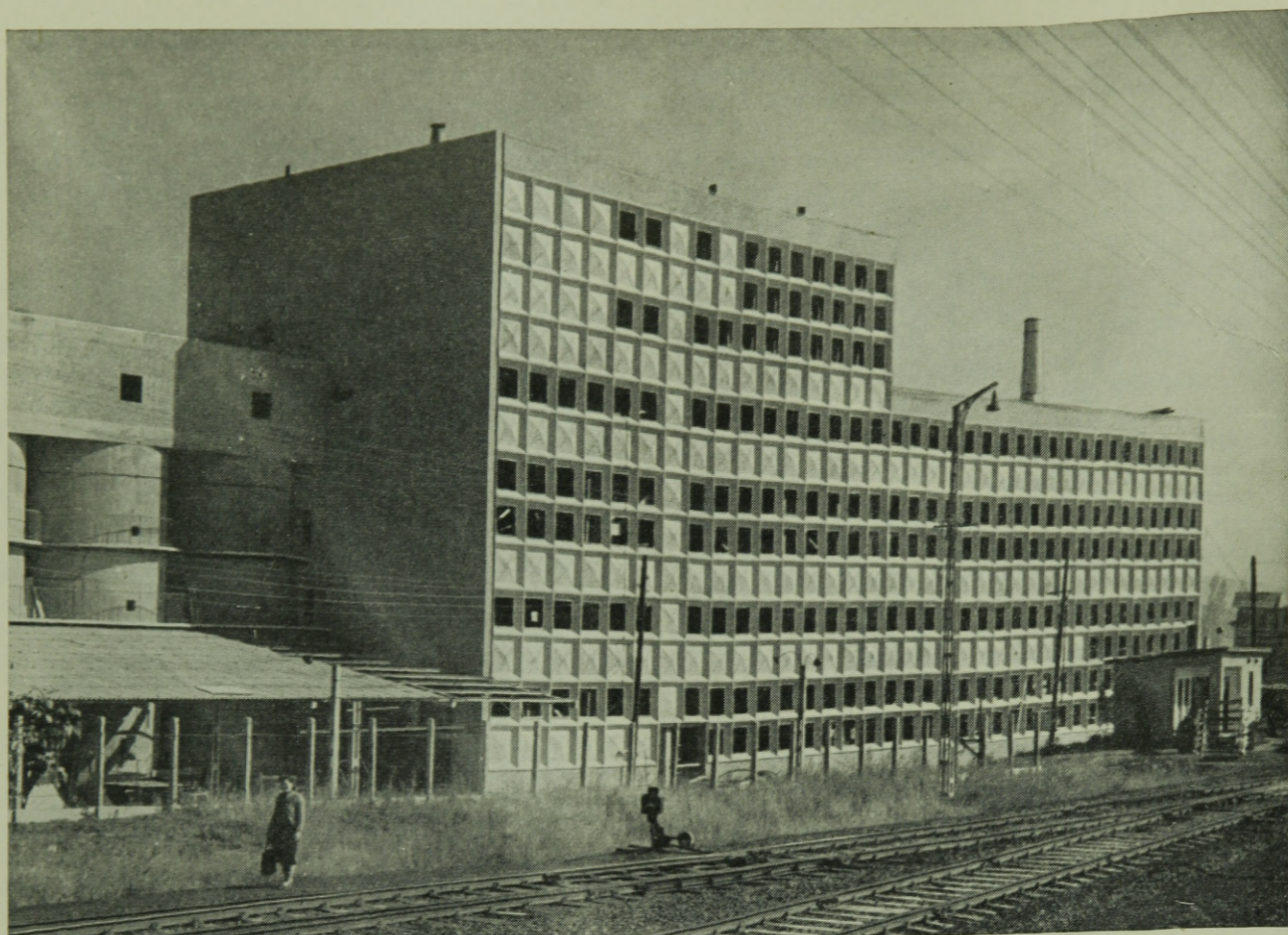
9. ábra. Balról jobbra: homogenizáló vasbeton silósor, őrő- és szárító épület
