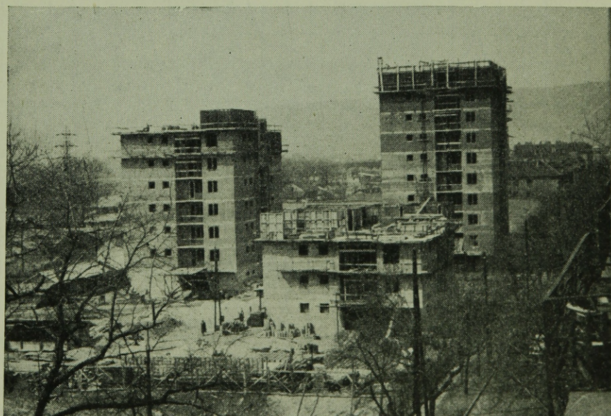
6. ábra. ÉTI fém- és állótáblás faszaluzat. Az építkezés általános képe
