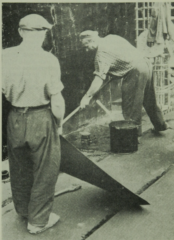
10. ábra. Vb. pillér szerkezeti vasaival áttört szigetelés
