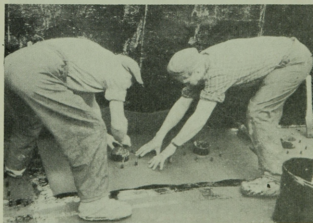
11. és 12. ábra. Csövekkel áttört szigetelés helyes elkészítése
