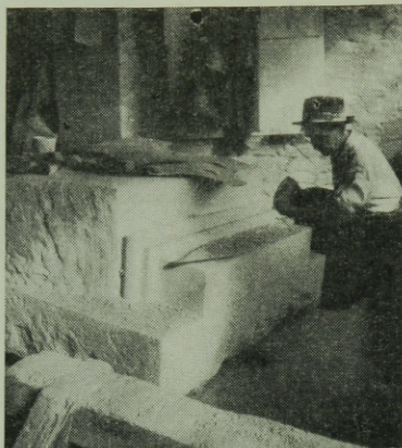
1. ábra. Kőfaragás kézi munkával
