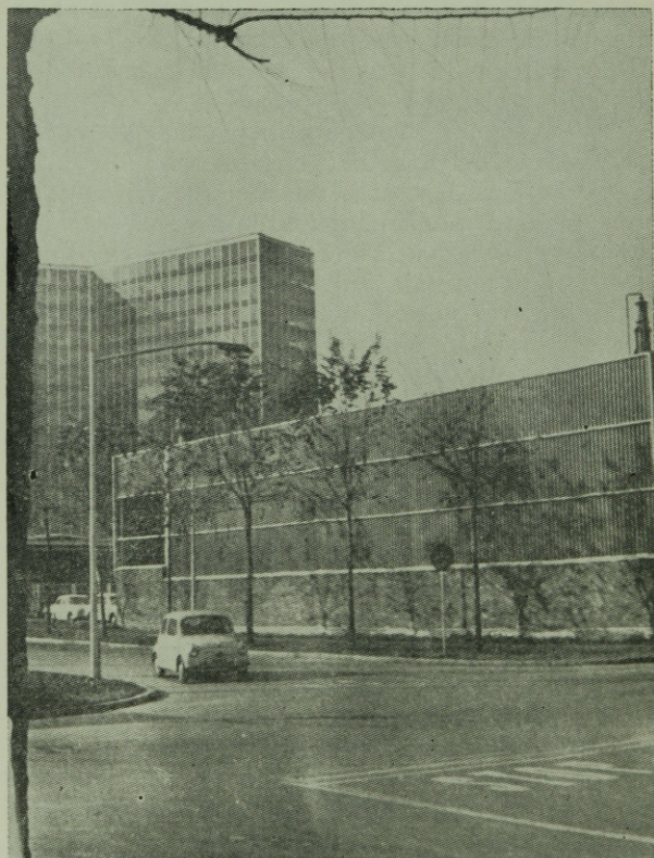
4. ábra. Üzemi épület, ENI, Milánó
