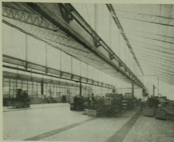
9. ábra. Hegesztett acélszerkezetű gépgyári csarnok (Schaeffler Höchstadt/Aisch). Fesztáv 20,00 m, a shed felülvilágítóknál 8,00 m fesztávú R-tartók. Tetőfödém könnyűbeton pallókból (Tervező: B. Gollner. Szerkezet: Gartner)
