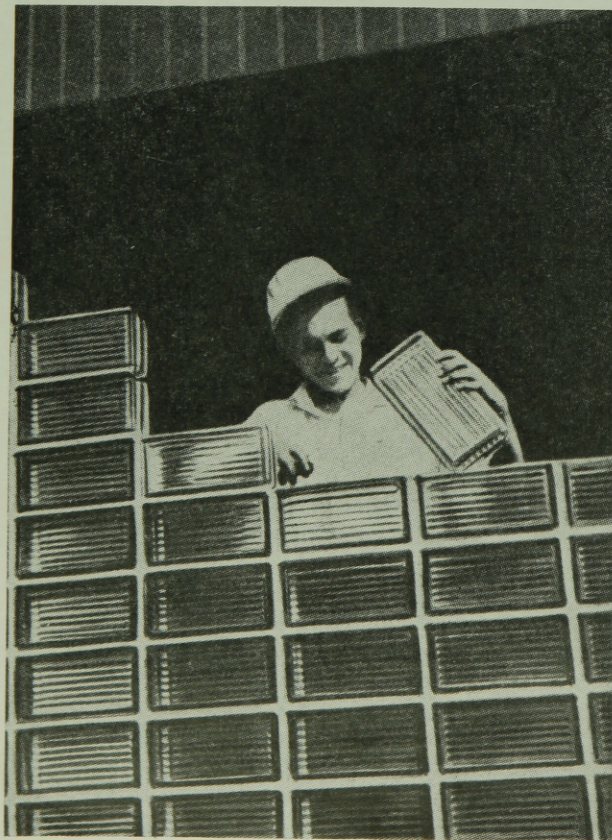
2. ábra. Üreges üvegtégla felrakása
