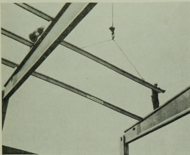
11. ábra. Előregyártott vb. szerkezetek, feszített tömörgerinces főtartó, T szelvényű szelemenekkel (Dywidag—Montagebau)
