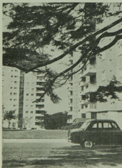
40. ábra. Anglia, hagyományos építésű toronyház
