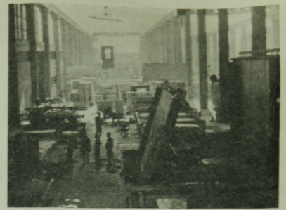
32. ábra. Aulnay Sous Bois-i Ciognet panelgyár
