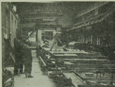
1. ábra. Hammers harántfalpanelek betonozása
