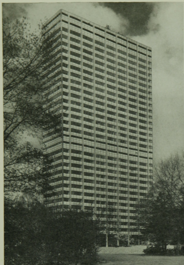
16. ábra. Bayer irodaház (Leverkusen/Rhein) 32 emeletes, alumínium kötényfalas épület. (Tervezők: Hentrich és Petschnigg)
