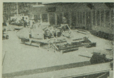
17. ábra. ABG aszfaltbedolgozó
