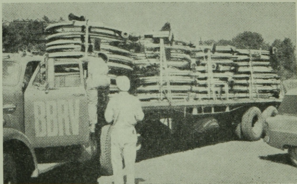
14. ábra. Feszítőkábelek szállítása kész állapotban.
