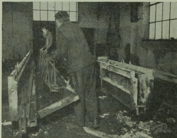
11. ábra. Kész szerelék sablonba emelése
