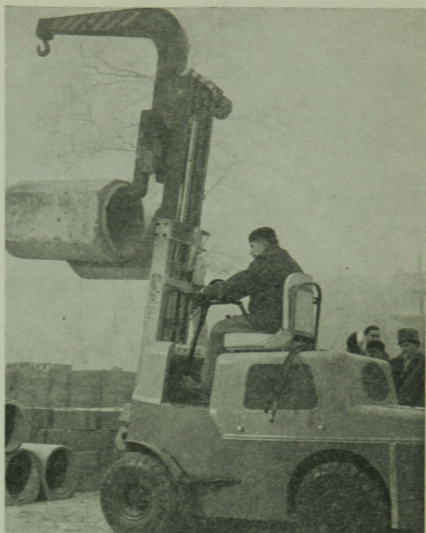
1. ábra. Nagyméretű betoncsövek emelése, segédeszköz a rakodóvilla
