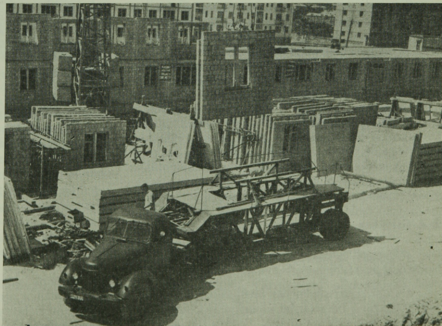
4. ábra. A külső falpanelok beemelése szállító kocsiról
