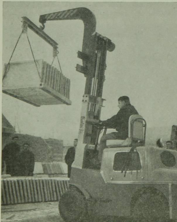
4. ábra. BH földmentálcák sorozat emelése, segédeszköz a daru és emelőtárho
