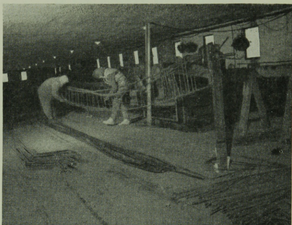
10. ábra. Előszerelés. Kengyelek kötözése
