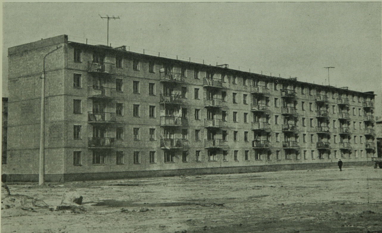
1. ábra. Üreges téglapanel lakóházak építése Kijevben. a) falpanelok elhelyezése; b) a kísérleti épület utcai homlokzata
