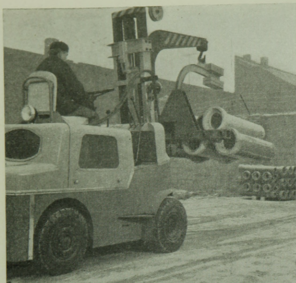
3. ábra. Kisméretű betonsövek emelése, segédeszköz a daru és emelőpatkó, háttérben kisméretű betonsövek egység rakománya rakodóvillás emeléshez
