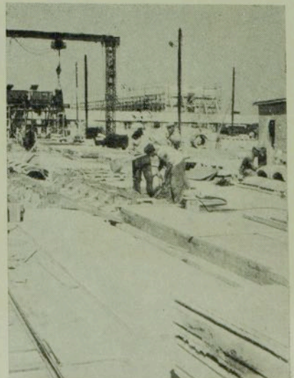
10. ábra. Helyszíni előregyártó telep
