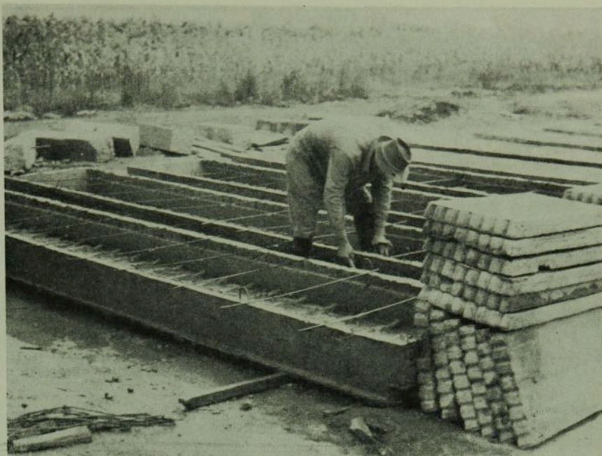
2. ábra. Irodaépületben alkalmazott típus födémelem készítése a tiszaszerdékényi előregyártó telepen
