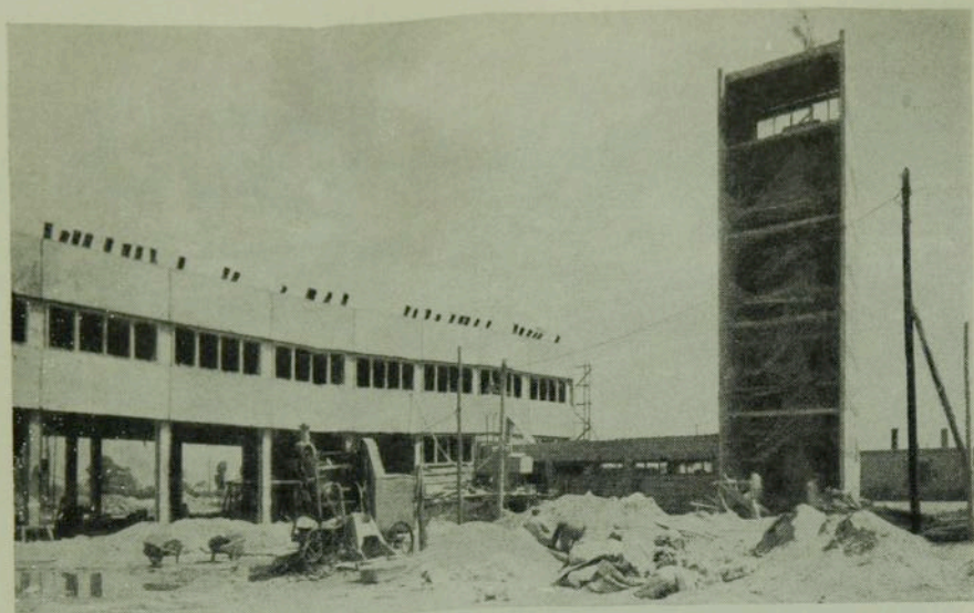
5. ábra. Karbantartóműhely daruzott részének szerkezeti váza, háttérben az irodaépület
