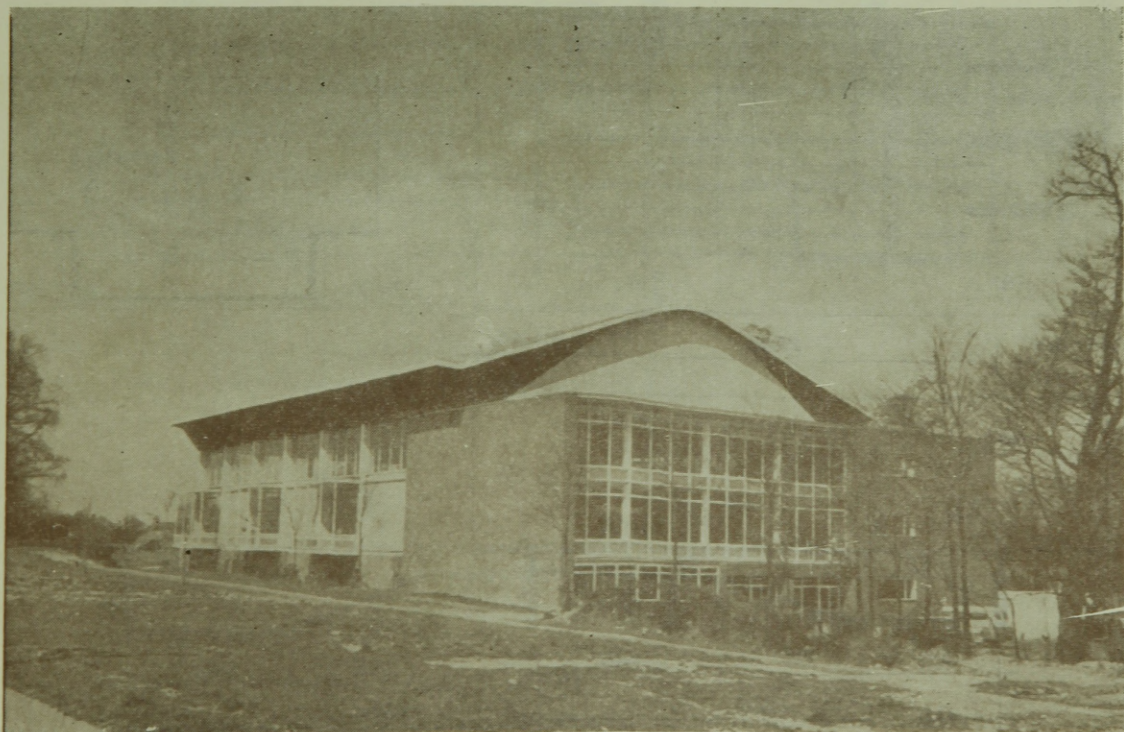
1. ábra. Fedettuszoda HARLOW-ban
