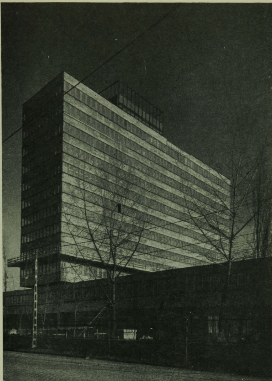
1. ábra. Váci úti homlokzat, építés közben
