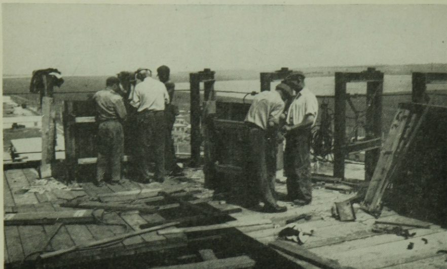
14. ábra. A csúszózsályzat szerelése a Peiner-állvány tetején
