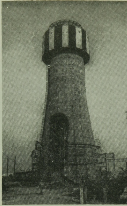
21. ábra. A mozgó munkaszintek védőponyvázata
