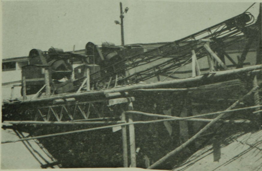
27. ábra. A betont szállító transzportőrök
