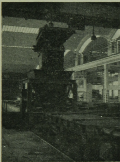
15. ábra. „Szim-Kár” földémpallógyártás terítőkocsival és automata betonkonténerrel
