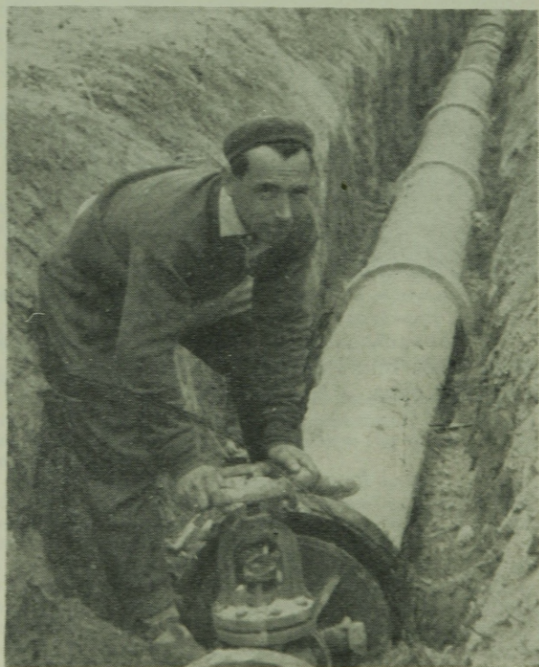
5. ábra. Nyomáspróba közdarab, Kuas-kötés szakaszba beépítve
