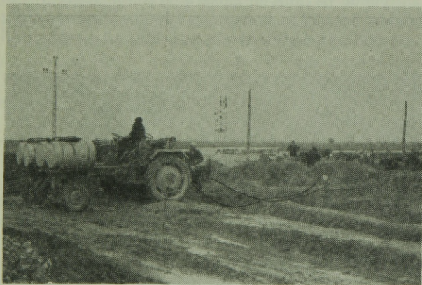
7. ábra. Nyomáspróba RS-09-es magasnyomású permetező traktossal
