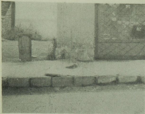
2. ábra. Úttest alakváltozása bányaművelés következtében
