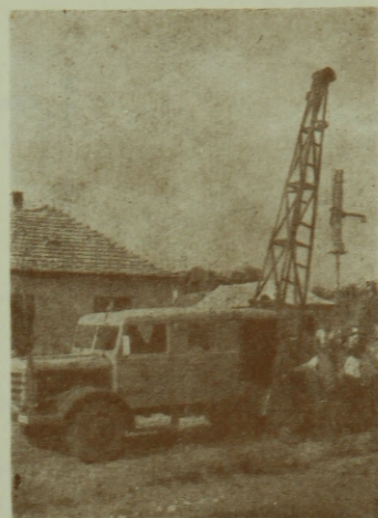
1. kép. Az FTI kútvizsgáló kocsija munka közben (Foto: Dr. Juranits Miklós)
