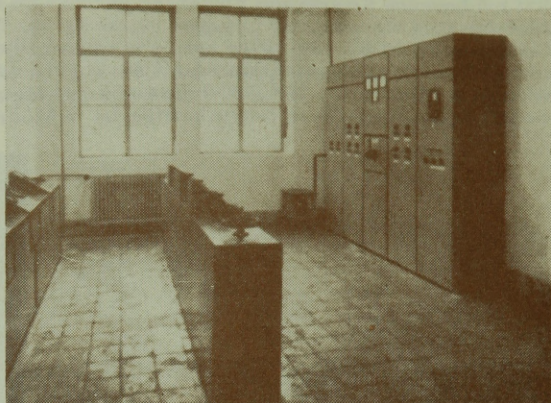
10. kép. A szilvásvári vízkezelő épületszűrő terme (Foto : Dr. Juranits Miklós)
