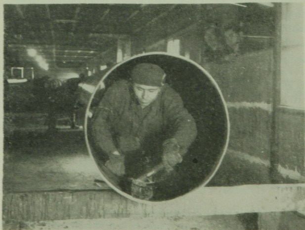
10. ábra. A cső belső szigetelése kézi erővel
