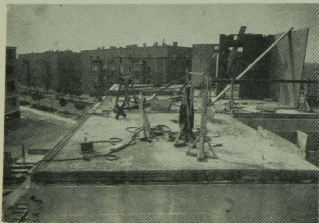
10. ábra. V-nóvasak és koszorú csatlakozása
