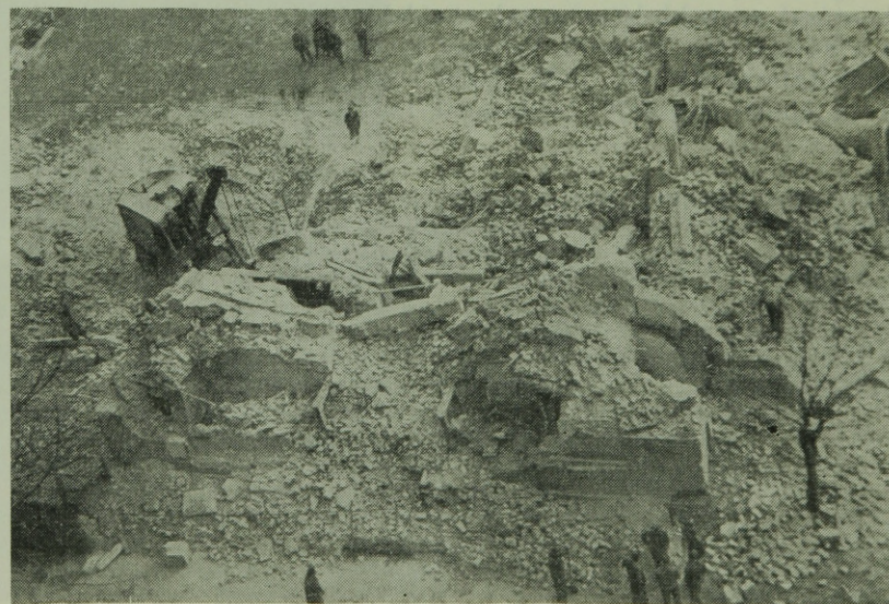
4. ábra: Gépi törmelékrakodás az Engels téri bontásnál
