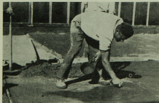
13. ábra. A perlitbeton felület cementtejes simítása
