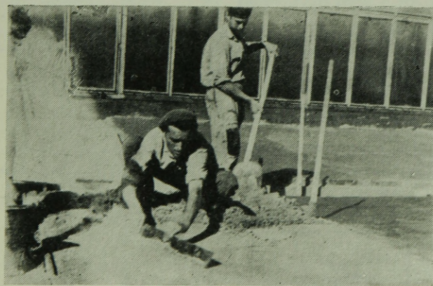
12. ábra. A perlitbeton felület lehúzósa „vasléccel”
