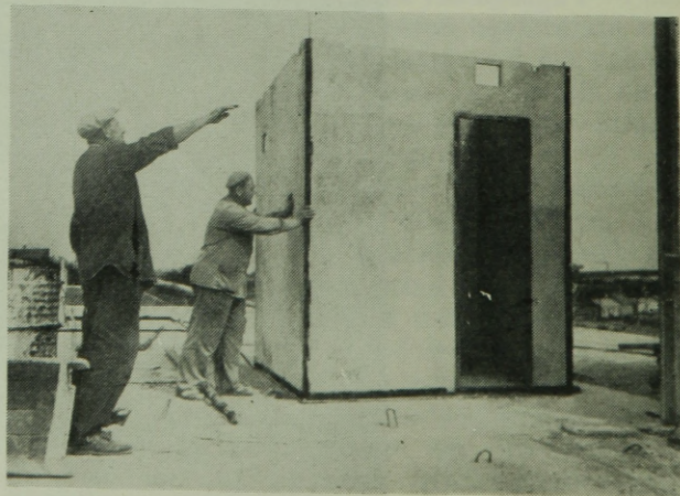
12. ábra. Térelem beemelése
