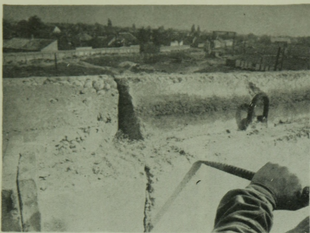
9. ábra. Gyártási méretpontatlanság „korrigálása”
