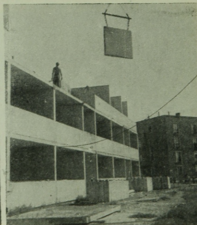
8. ábra. Harántfalpanel beemelése
