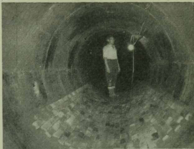
10. ábra. Úttörő-utcai csatorna a klinkerléc burkolat elkészülte után
