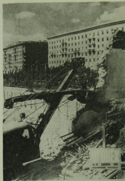
6. ábra: Bontás kotróval a Szovjetunióban
