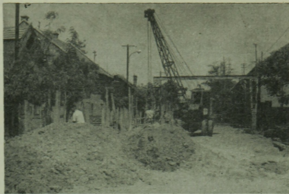
5. ábra. E-302 típusú kotrógép a munkaárok felső részét markolja
