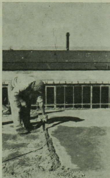
14. ábra. A perlitbeton tömörítetlen szélének eltávolítása
