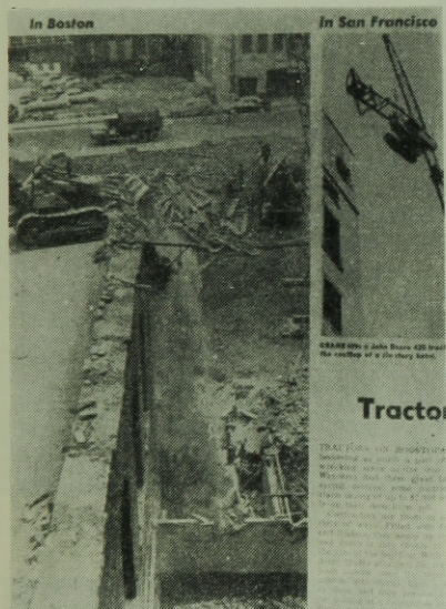
5. ábra: Bontás dózerrel és daruval az USA-ban
