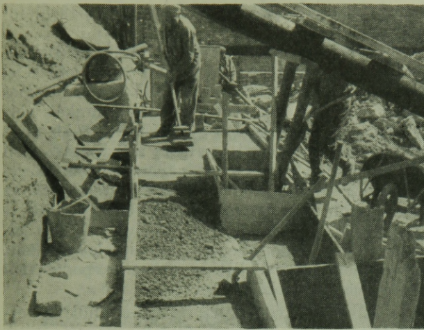
8. kép. Az udvar felőli vb. talpak és v.b. átmeneti test behozása (Foto: Gácsi János)
