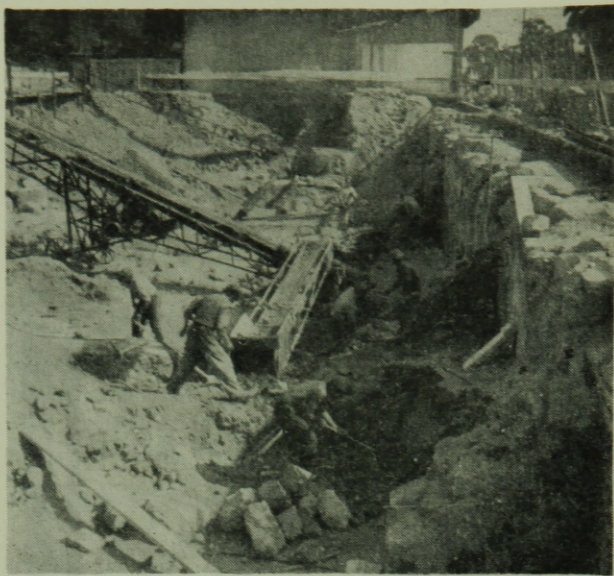
4. kép. A munkagödör a földkiemelés után. (Foto: Valkó Gábor)
