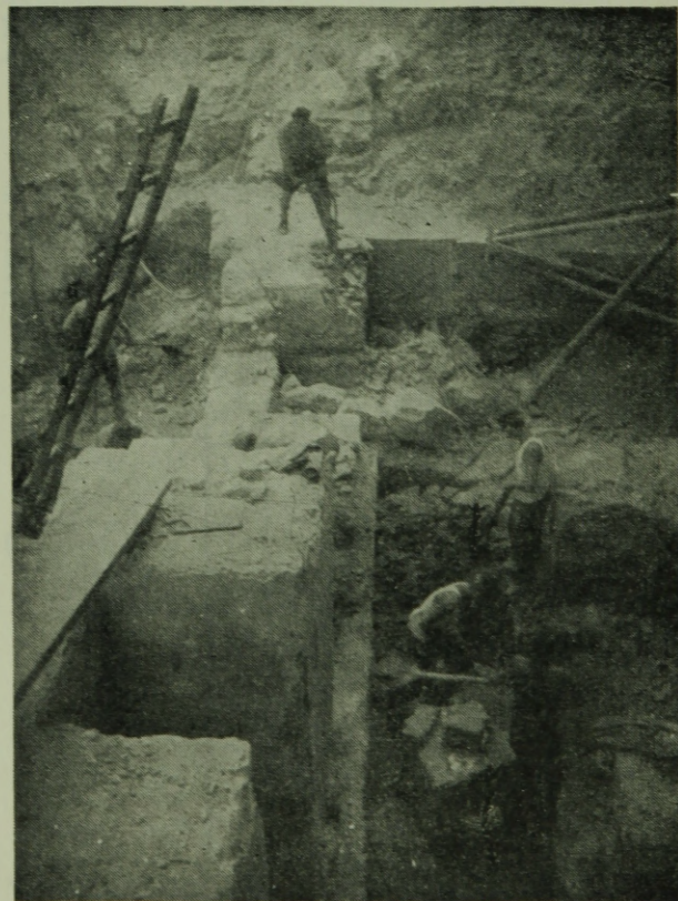
5. kép. A kazánházi teknő területére eső fa- és gépalapmaradványok bontása. (Foto: Valkó Gábor)
