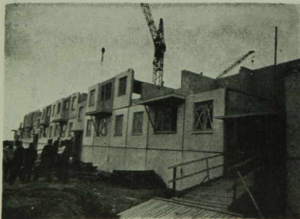
9. ábra. Paneles épület szerelése Leningrádban
