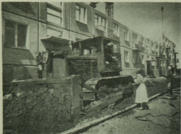
15. ábra. I-464-típusú épület szerelése
