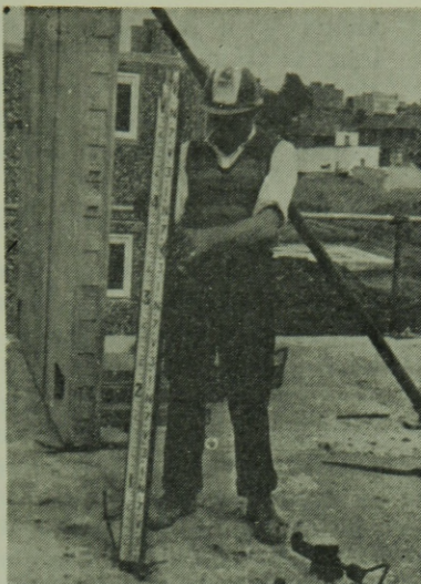
6. és 7. ábra. Falpanel felfekvési magasságának a beállítása
