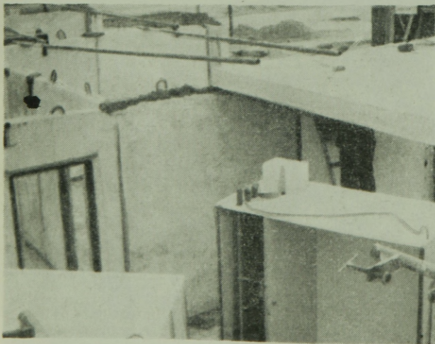
11. ábra. B/3 jelű vizeskabin az épületen
