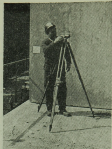
6. és 7. ábra. Falpanel felfekvési magasságának a beállítása
