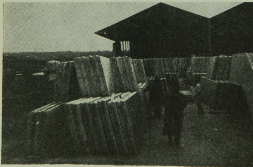
14a ábra. Panelek tárolása a gyártóüzem előtt
