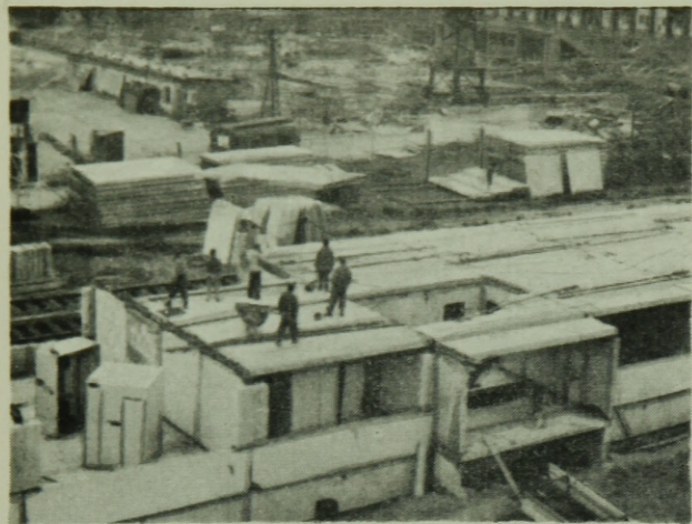
17. ábra. Kassa : Nagyfesztávú paneles lakóépület szerelése
