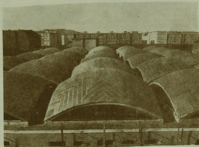
20. ábra. A Kismotor és Gép- gyár 12 × 12 m pilléraszterü lefedő monolit csehsüveg héjszerkezete
