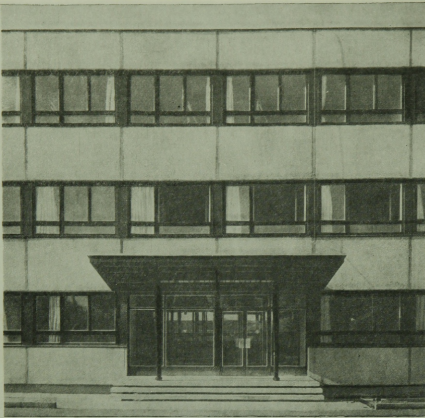
2. kép. Debreceni Orvosi Műszergyár irodaépület főbejárata
