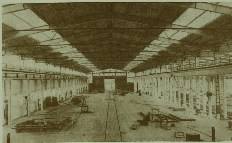
11. ábra. A Csepel csőgyár acél-szerkezetű vonóvas, ívtartóként működő csarnoka
