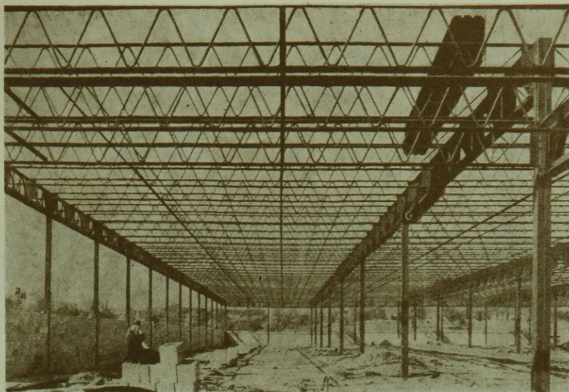
37. ábra. Macomber rendszerű csarnok építés alatt
