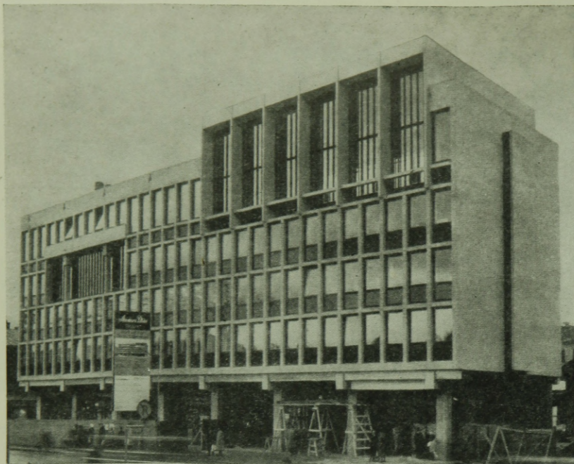
2. ábra. A södertäljei újjvárosháza (építész : A. Lindqvist). A teljes homlokzati felület nyers betonnal van megoldva
