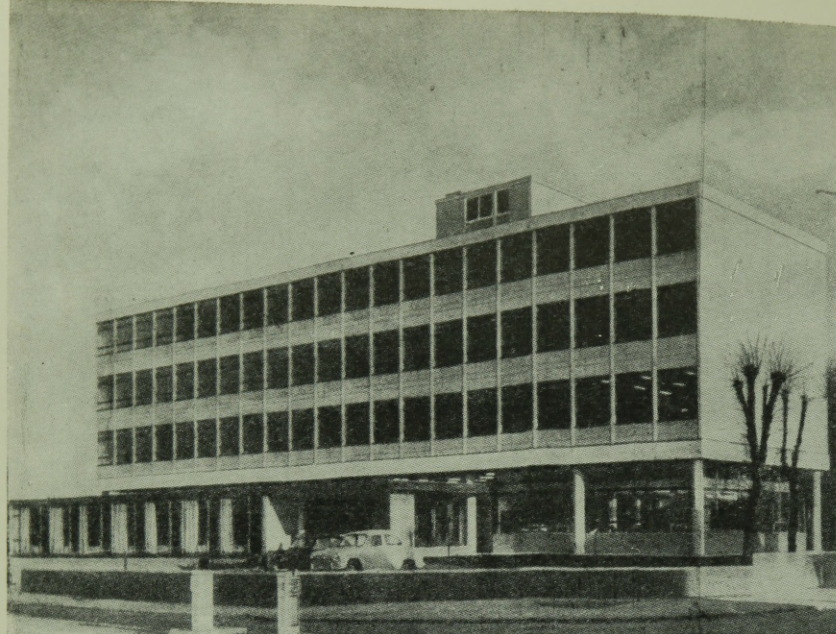
4. ábra. A Brit Vasutak irodaháza Cambridge-ben intergrid rendszerű előregyártott vb. elemekkel. Tervezők: A. K. Terris, Mice és H. H. Powell, B. Arch. (Liverpool), FRIBA
