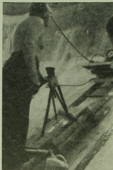
4. ábra. Az injektáló sajtó munka közben
