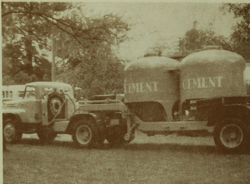
2. ábra. Csepel D 450 N5-1 típusú 7 tonnás nyerges cementszállító gépkocsi
