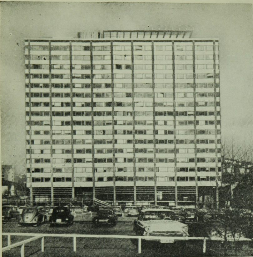
7. ábra. A Stuttgarti I. Kolehliengebäude homlokzata.
