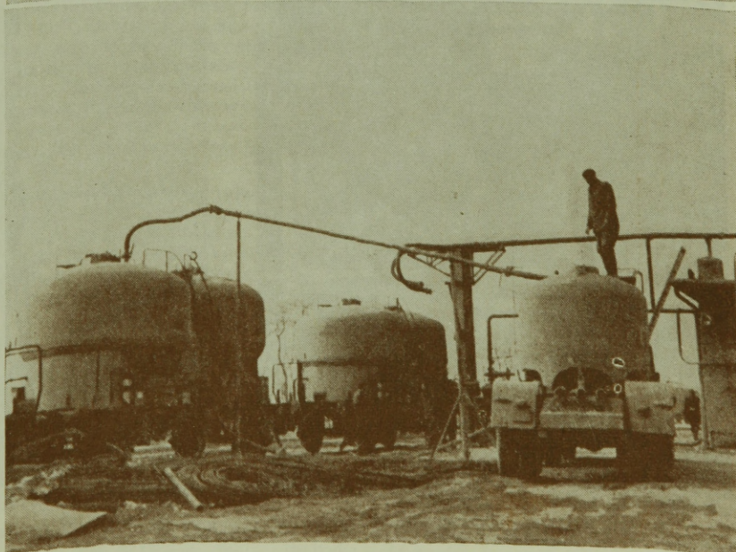
7. ábra. Átfejtés vasúti kocsiból közúti kocsiba „kombinatív” szállítás esetén
