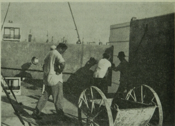
5. ábra. Új élet park nagypaneles lakóépület, parapet falelem elhelyezése
