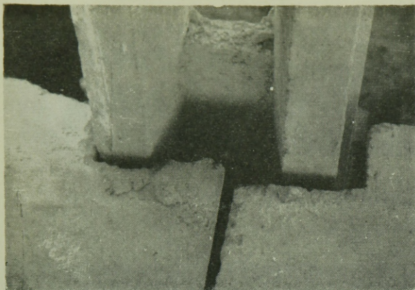
4. kép. Pillér és panelek csatlakozásánál utólagos összeszerelés nélkül kialakított csomópont
