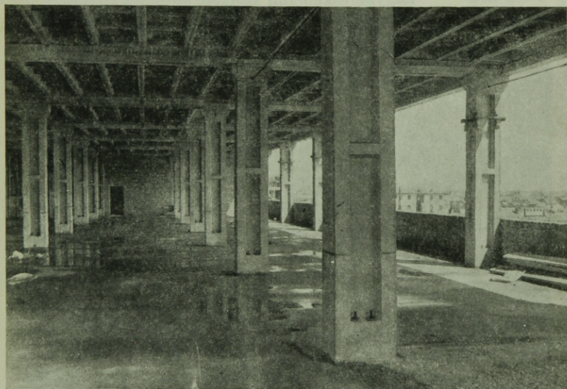
9. ábra. Textilraktár belső képe a vasszerkezetű ablakelemek elhelyezése előtt
