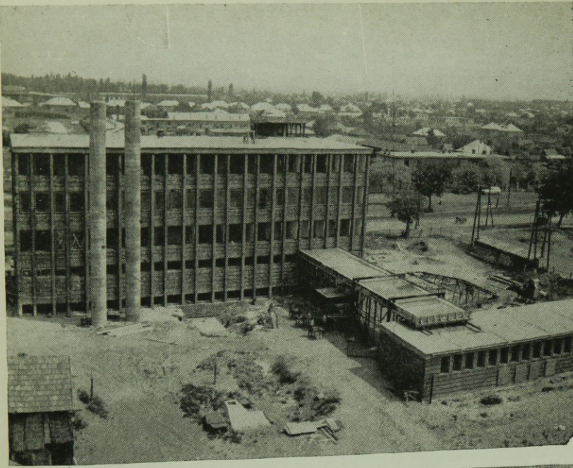
2. ábra. Bejárat épületcsoport építés közben
