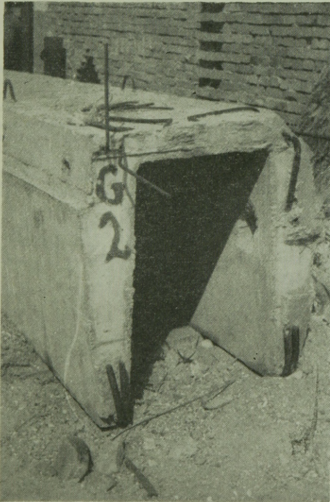
8. kép. A főtartók alsó fő vasbetétei a felfekvéshez kialakított acéllemezen fekszenek, a kis keresztmetszetben belül közvetlenül egymás mellé szorulva
