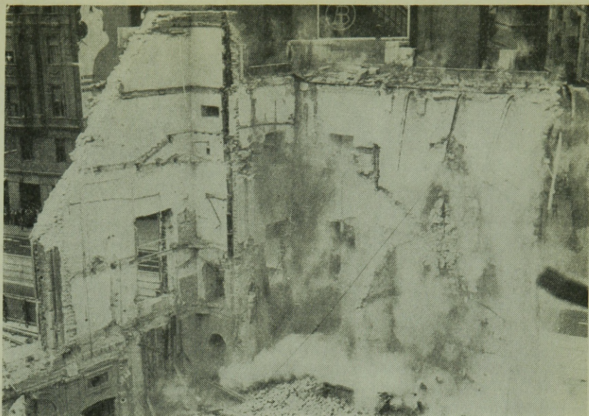
10. ábra. Jól sikerült robbantás egy részlete a Nemzeti Színház bontásánál (Szerző felvétele)
