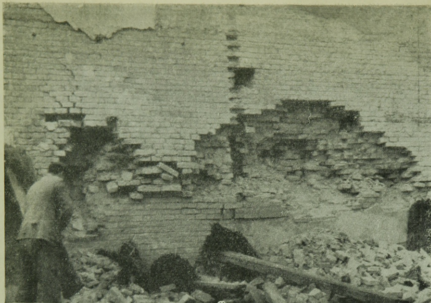
9. ábra. Tűlfúrás miatti ellentétes oldalon kialakult kidobás (Szerző felvétele)
