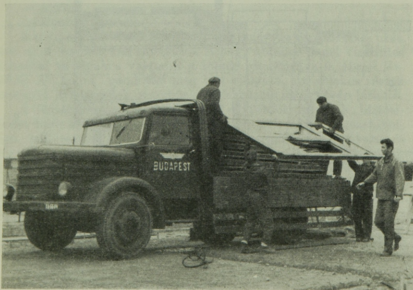
15. ábra. Falpanelek szállítása tehergépkocsin
