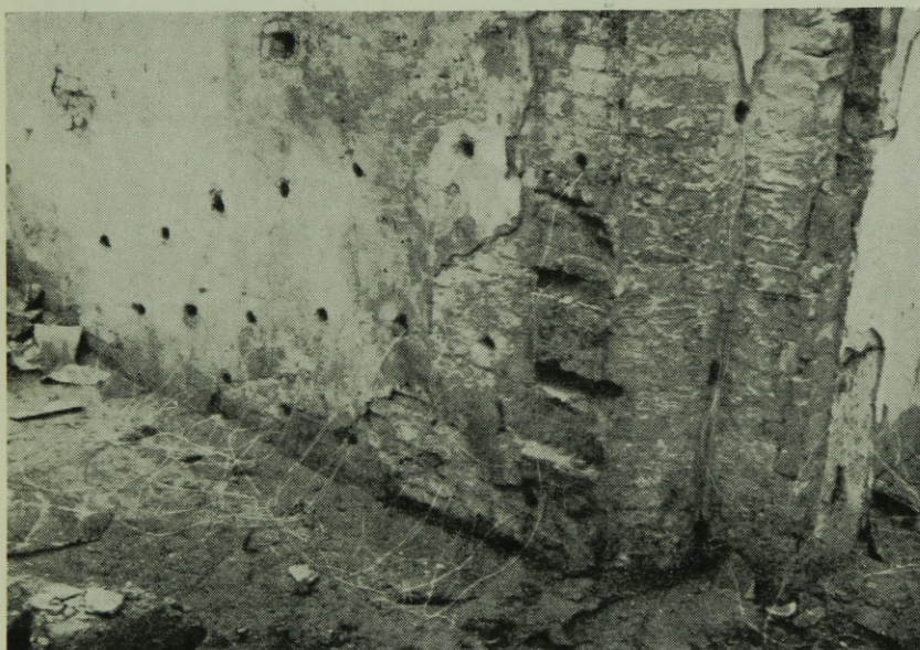
7. ábra. Ék-alakú sarok töltet-elrendezés (Szerző felvétele)
