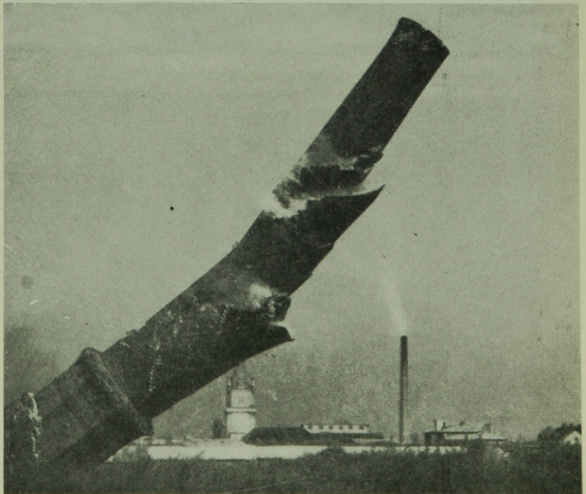
5. ábra. Kémény adott irányba való eldöntése (Szerző felvétele)
