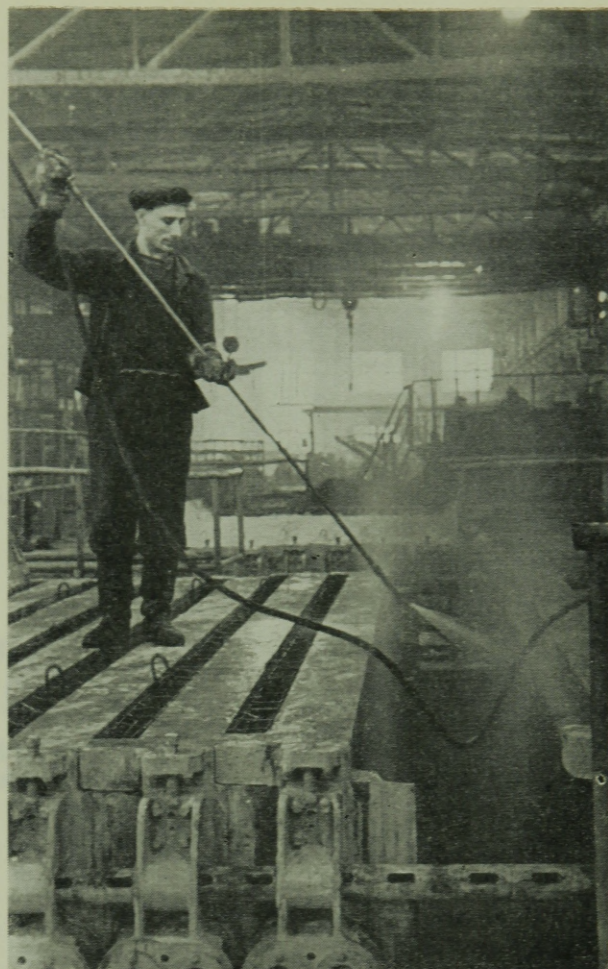
2. ábra. A csoportzsalu rekeszfalainak olajozása
