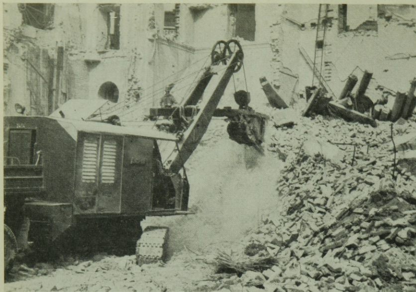
12. ábra. Robbantás utáni gépi rakodás (Szerző felvétele)
