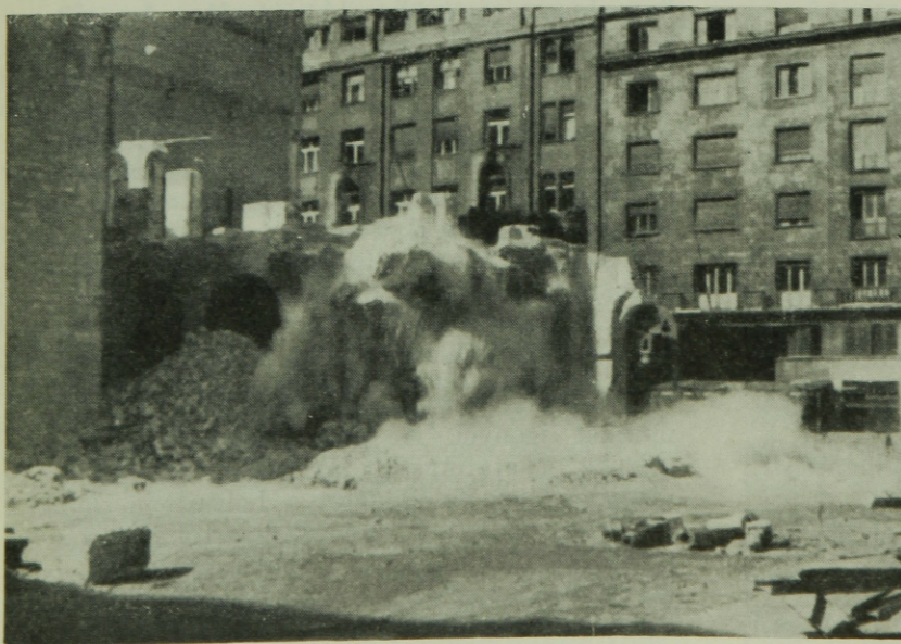
3. ábra. Falszakasz beomlasztása (Szerző felvétele)
