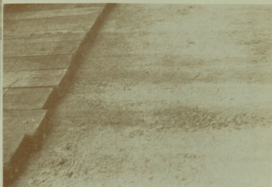
21. ábra. A zsaluzatból kikerülő betonfelület műanyag betétek alk. nélkül
