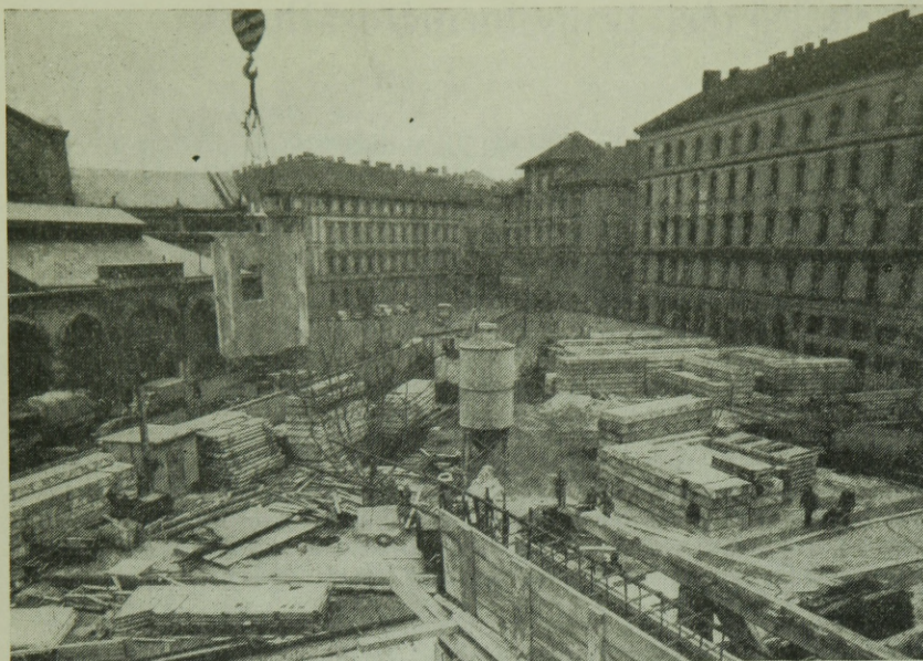
1. ábra. Előregyártott földém és cellafalak beemelés előtt
