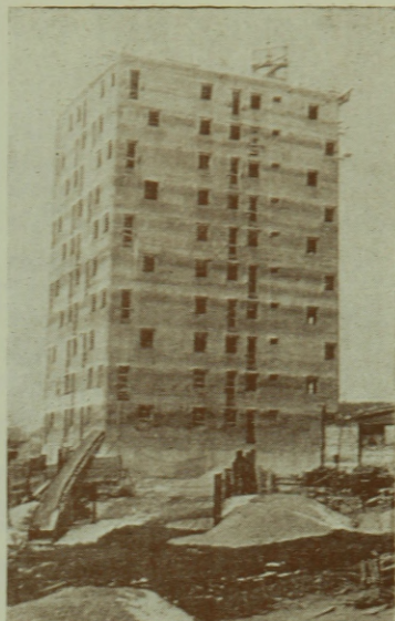
58. ábra. Csúszózsályuzattal kivitelezett könnyűbeton falszerkezet felületi jellege, Budapest, 1965. febr.
