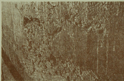
44. ábra. Tömörítéskor a híg cementhabarcs „fröcsköl”
