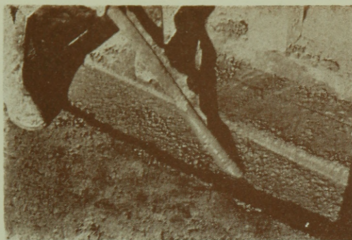
46. ábra. A vibrátort lassan ki lehet húzni, ha a plasztikus beton egyenletesen elhelyezkedett a gödörben
