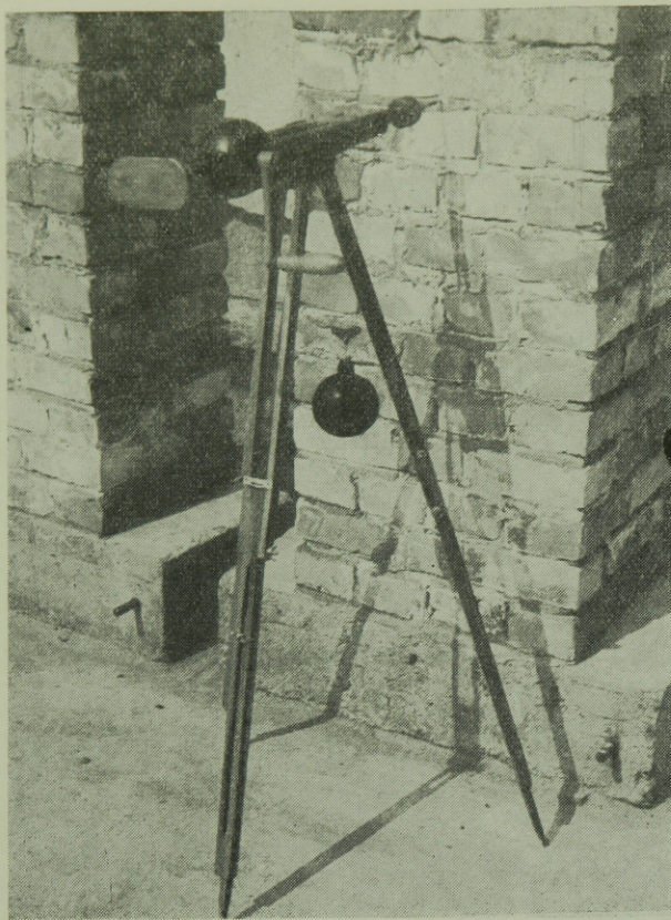
4. ábra. A „Habarcsvizsgáló” — HF — készülék üzemkész állapotban, támasztóállványon
