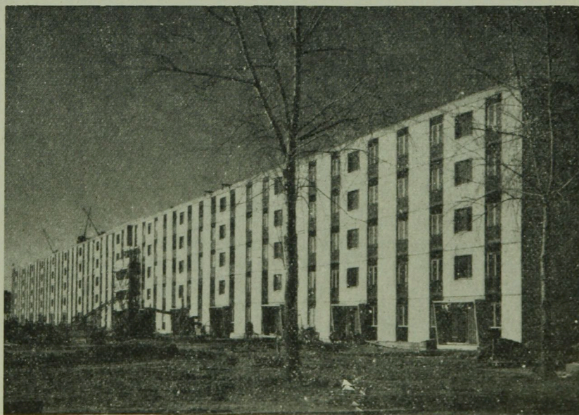
11. ábra. Háromfogatú szekcióval épített dunaújvárosi panelszerkezetű lakóház
