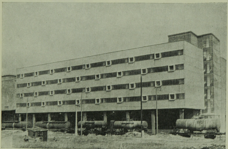
9. ábra. Tiszamenti Vegyiművek, Szuperfoszfát-granuláló üzem, Szolnok, 1961.
