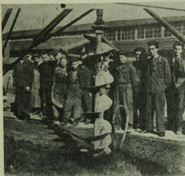
7. ábra. Távvezeték-oszlopok állítására szerkesztett fűrógép rövid, fűrt cölöp készítésére is alkalmas
