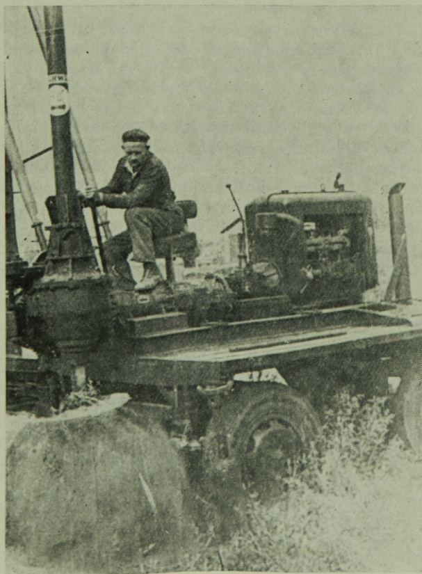
3. ábra. A Highway-féle fűrőberendezés fűrés közben
