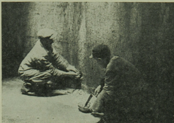
2. ábra. Vízbetörés helyének megnyitása a vagonbuktató betonfalán
