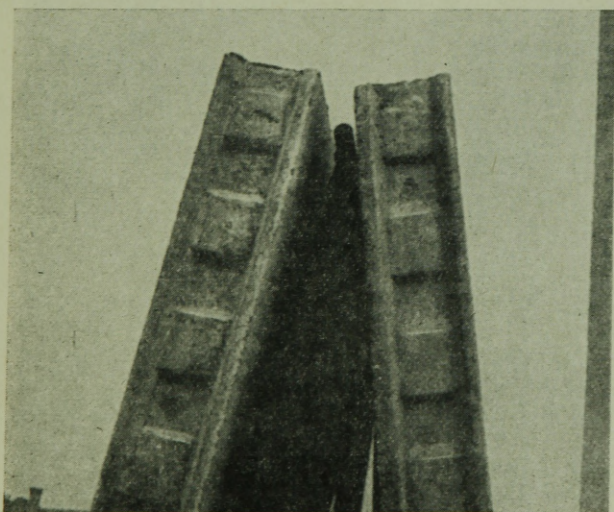
9. ábra. Fogas oldalélű üreges szerkezeti harántfalpanel
