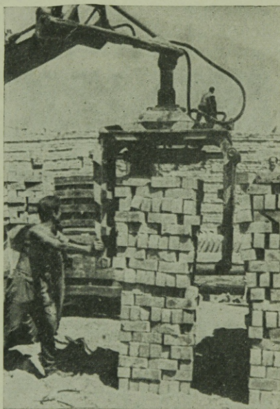
5. ábra. Egységrakományos építéshelyi tárolás
