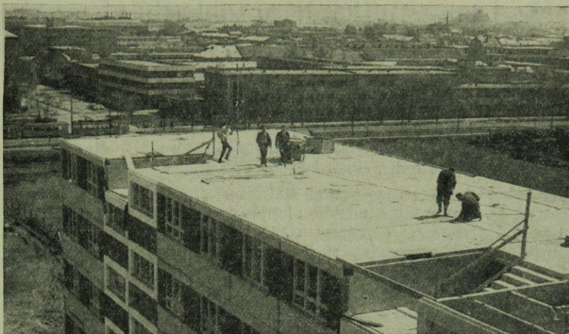
4. ábra. A földécsomópontok hegesztett kapcsolatának készítése
