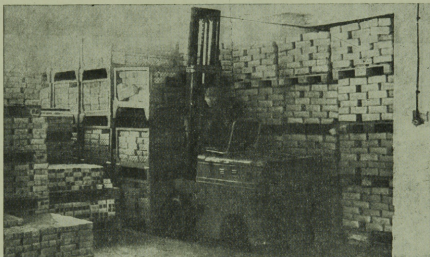
22. ábra. Oldalfalas rakodólapok emelővillástargoncás rakodása, szállítása
