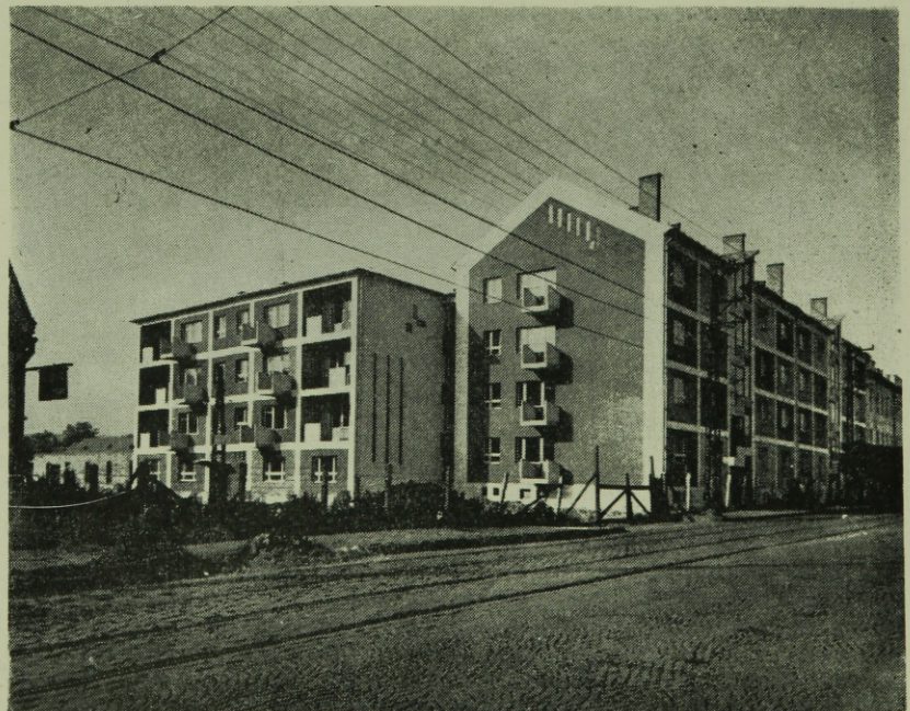
11. ábra. Miskolc. Tizeshonvéd utcai lakóépület
