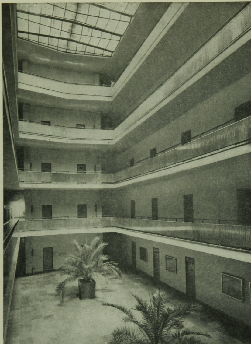
8. ábra. A főépület belső tere
