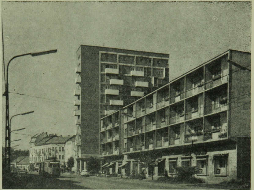
10. ábra. Miskolc. Ady-híd BajcsyZsilinszky út beépítése
