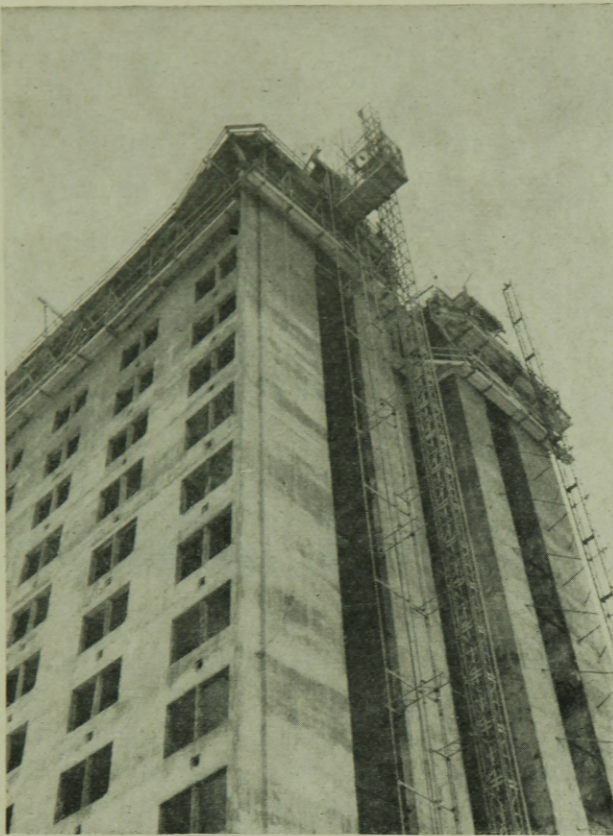
4. ábra. 15 emeletes magasház építése csúszózszaluzással (1965).
