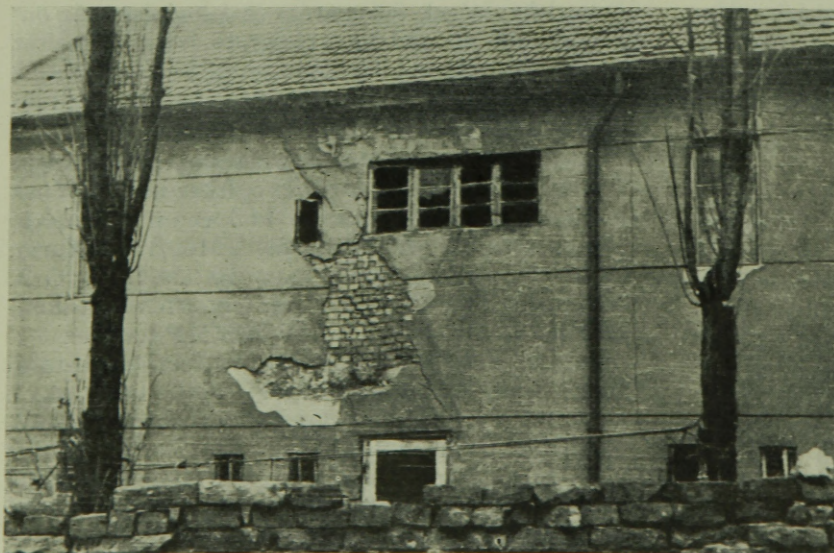
1. ábra. Budapest XIII. kerület. A tőzeg és szerves talaj még nagyobb épületekben is komoly károsodást idézhet elő
