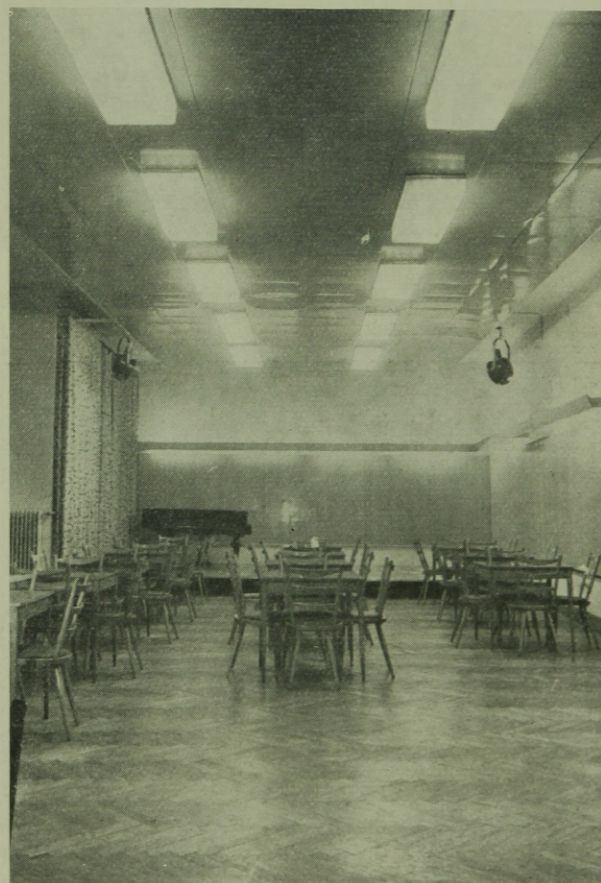
4. ábra. Kultúrterem kazettás mennyezetfűtéssel
