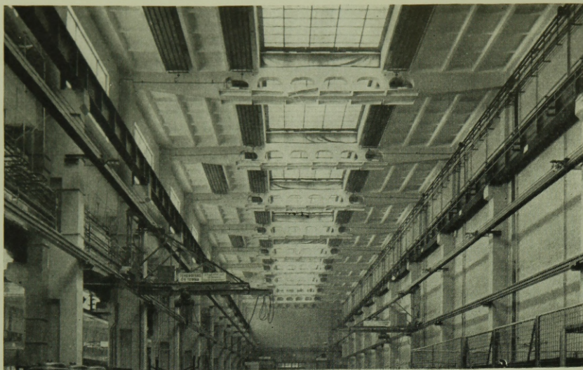
5. ábra. Ipari csarnok sugárzóernyős fűtéssel
