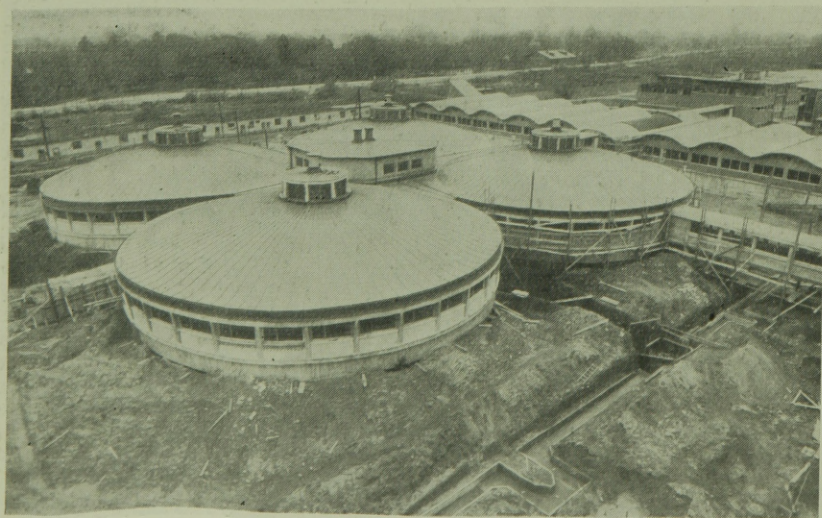
2. ábra. A II. ütemben épített 4 db új derítő
