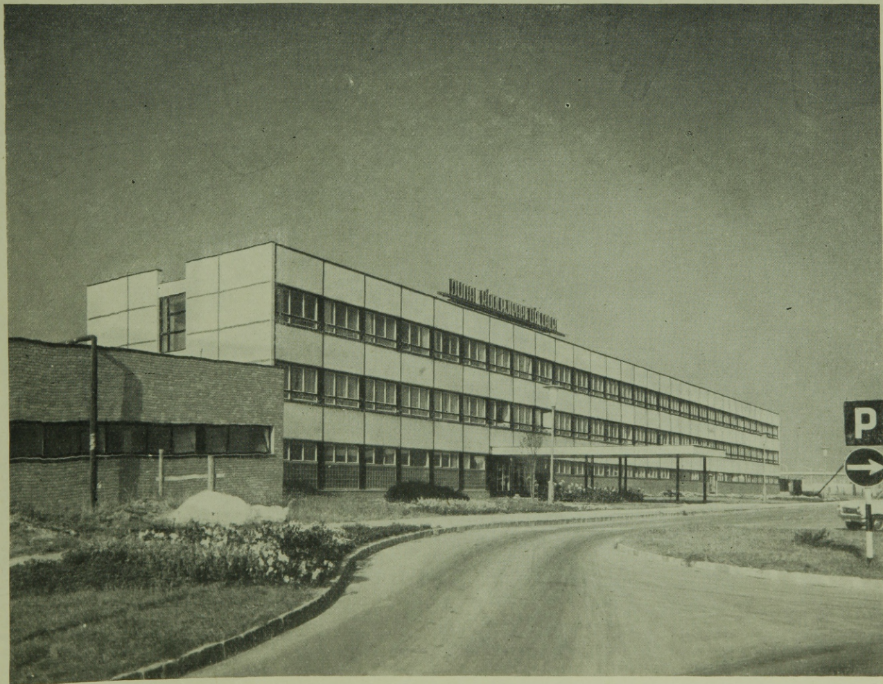
Igazgatósági épület főhomlokzata
