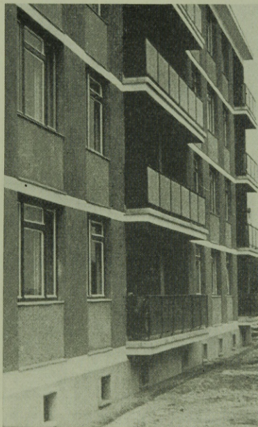
2. ábra. Vezér utcai lakótelep, lábazat és erkélyszegély előregyártott műkőelemekből
