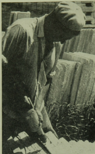
4. ábra. Helyezésre szolgáló lyukak gépi fúrása előregyártott lábazati műkölapokon
