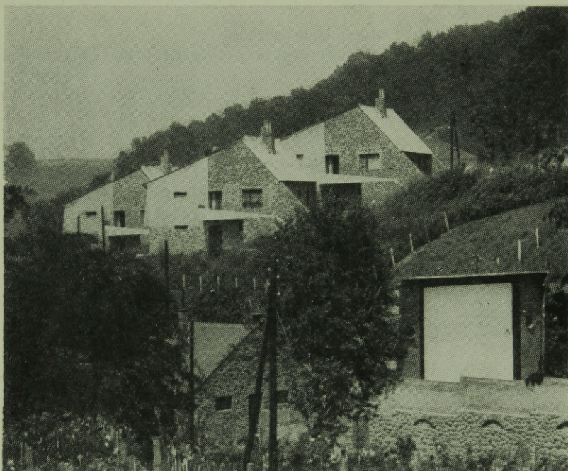
11. ábra. Komló. Csoportosan telepített kétszintes orvoslakások
