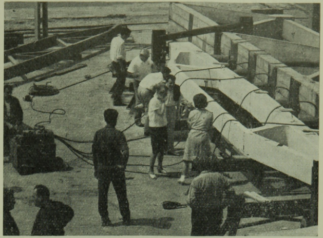
7. ábra. A 12 m-es tartó próbatörése
