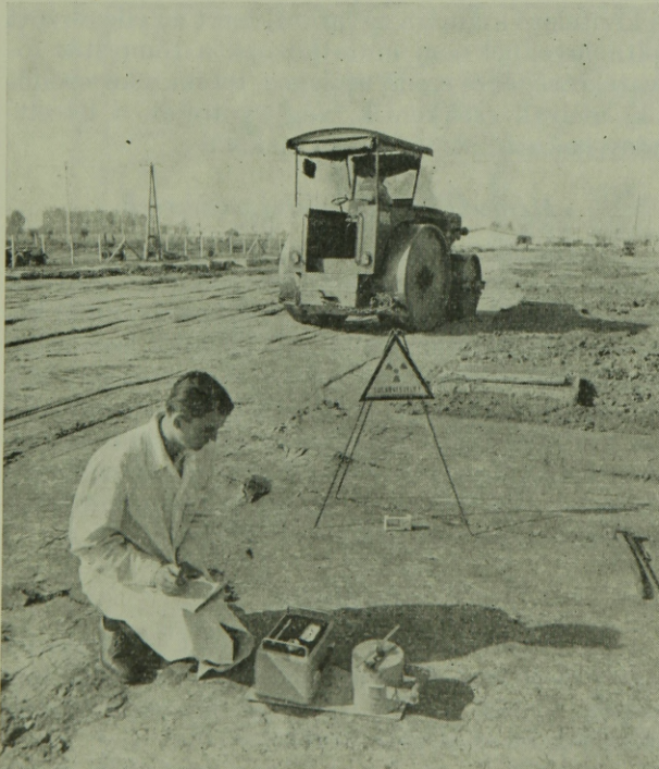
2. ábra. Felszíni talajtömörtség-mérés VATUKI műszerrel homoktalajon
