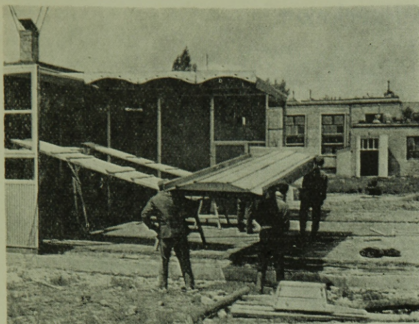
13. ábra. Tetőpanel felhelyezés előtt
