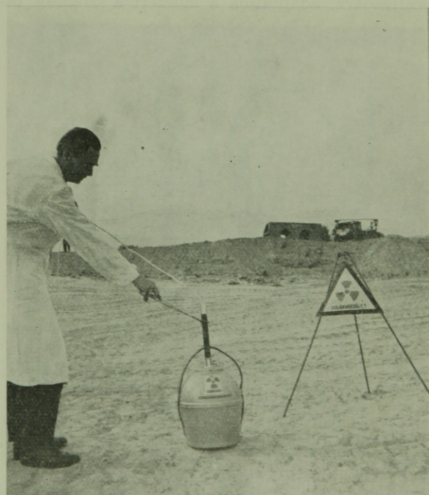
4. ábra. AKI nedvességmérő neutronszonda kiemelése a paraffin konténerből
