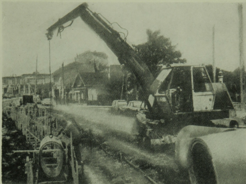
9. ábra. Hidraulikus, univerzális kotró daruszereléssel csatornafektetést végez
