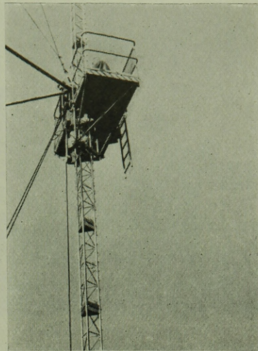
13. ábra. FH 1600 kapaszkodó munkaállvány munkahelyzetben
