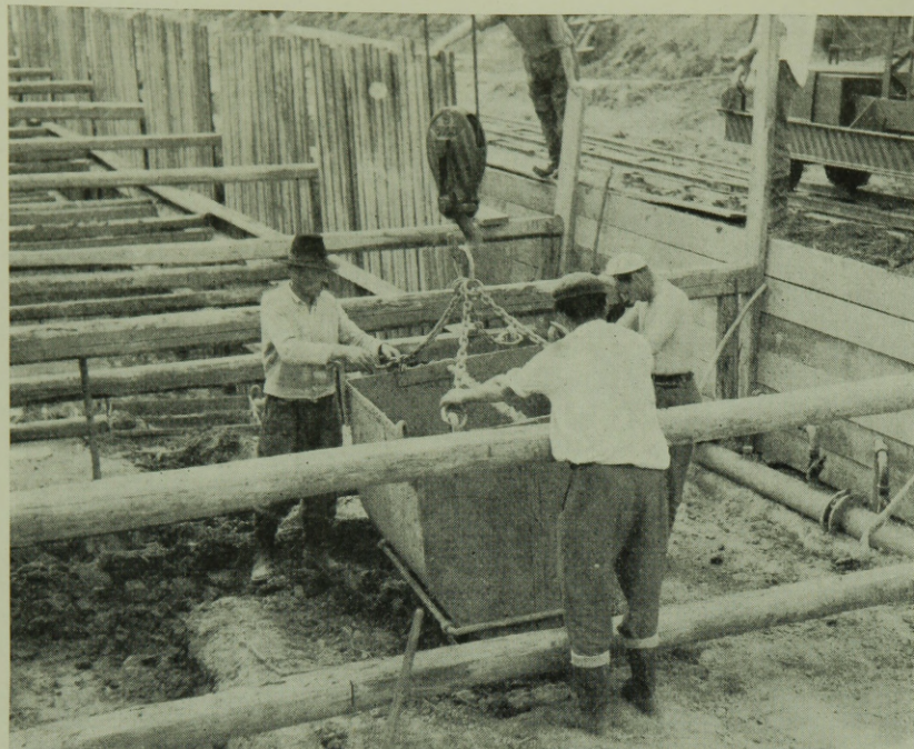
4. ábra. Földkiemelés 0,8 m 3 -es konténerrel
