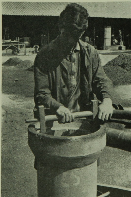
11. ábra. Csőtok méretellenőrzése
