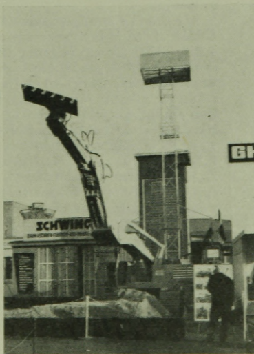
31. ábra. 431 típusú Schwing Exakt-kotró
