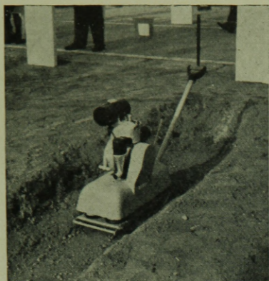
19. ábra. GSD 20 vibrációs ároktömörítő
