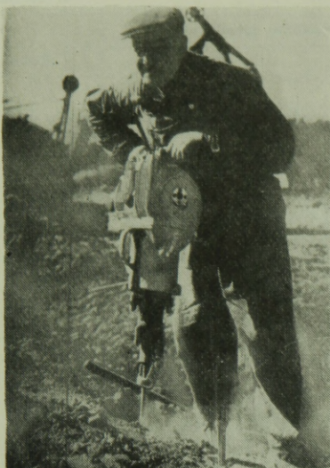
6. ábra. PIONÄR típusú robbanómotoros svéd bontókalapács
