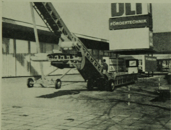
27. ábra. T 335 típusú vedersoros rakodógép
