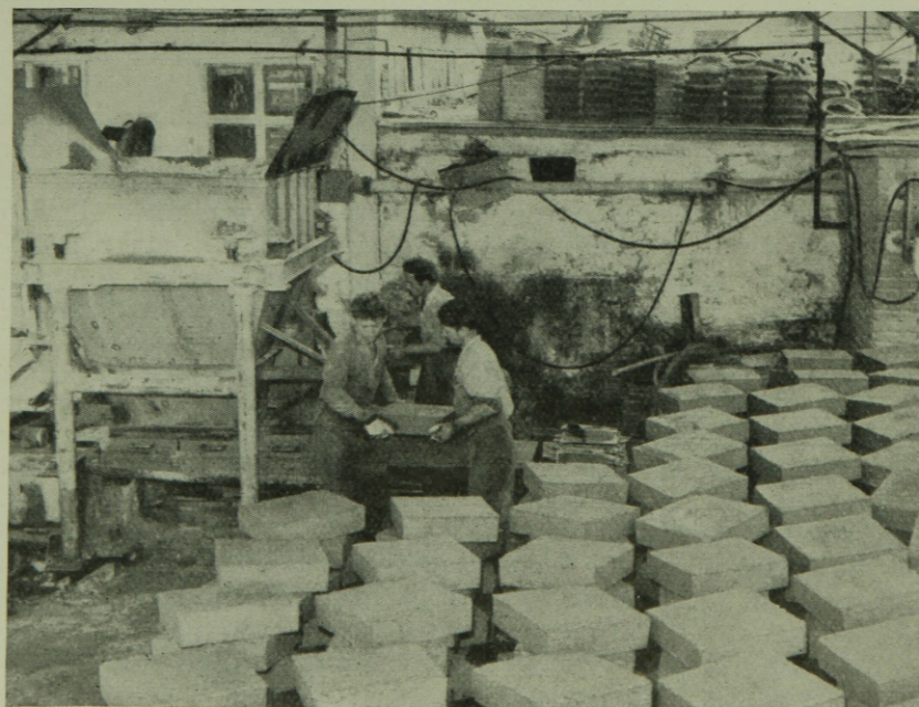
3. ábra. A blokkszerű elemek gyártása kiborítós módszerrel
