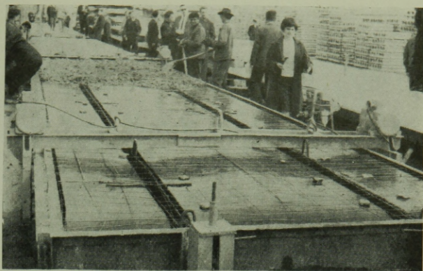
1. ábra. Kettős T keresztmetszetű panelek gyártása Lengyelországban
