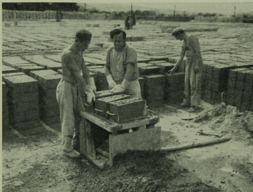
2. ábra. Bányaékgyártás kis vibroasztalon
