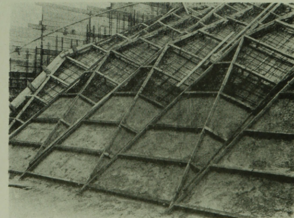
13. kép. Kész vasbetonlemez-részlet képe
