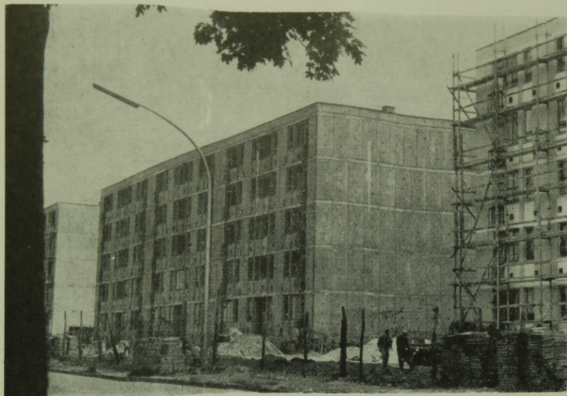
5. ábra. Az összeszerelt lakóépület
