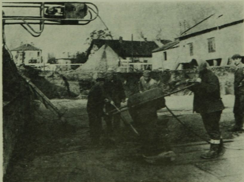
4. ábra. A talajcsere réteg tömörítése
