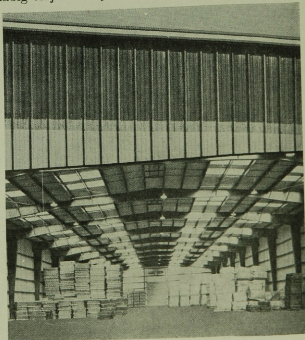
3. ábra. Könnyű acélszerkezetű csarnok homlokzata és belső képe
