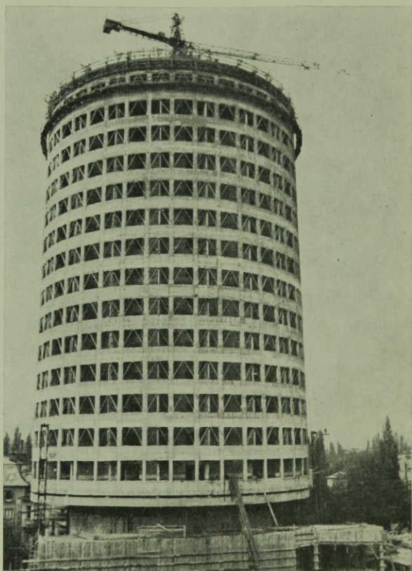
16. ábra. Az öntött falszerkezet befejezés előtt
