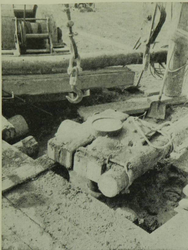
6. ábra. A béléscső betonnal töltve a robbantás előtt
