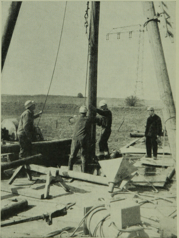
3. ábra. A fűrőcsővek felhúzása
