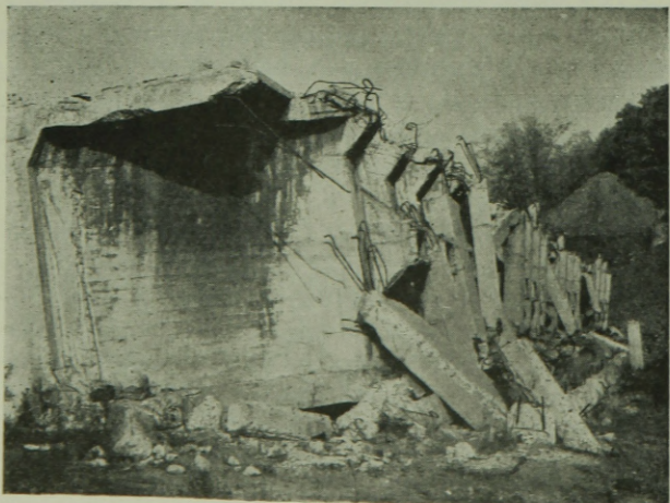
2. ábra. Vb. siló eldöntése a tartó-lábak elrobbantásával
