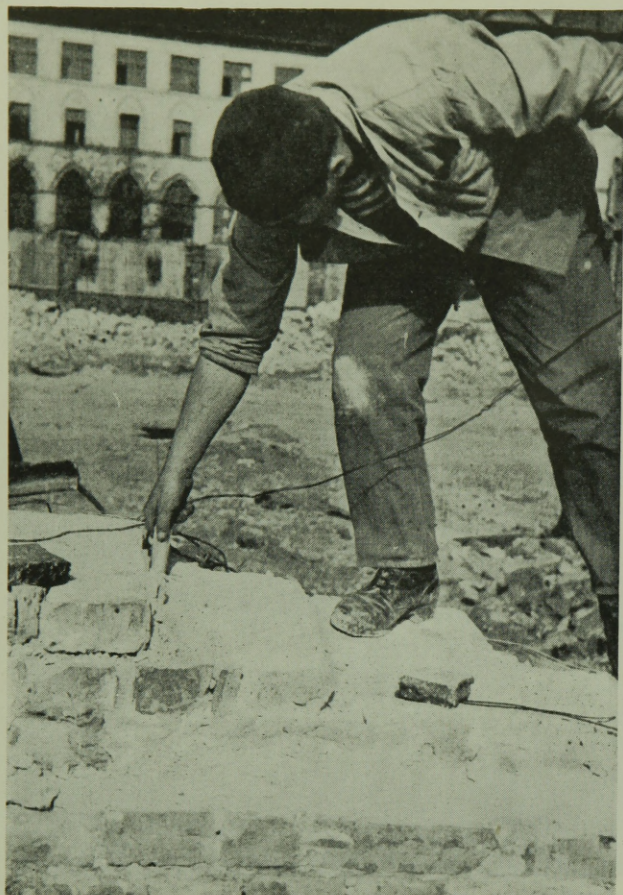
4. ábra. Téglalaptest robbantótöltetének elhelyezése
