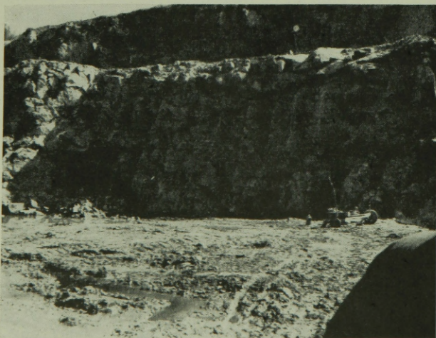
5. ábra. Völgyzáró gát alapgyödrének kirobbantott része
