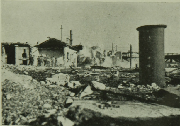
1. ábra. Alaptestek szétvetése a budapesti volt elevátorház bontásánál
