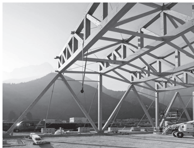
Az agardoi kongresszusi és kiállítási csarnok szerkezetépítése, tervezők: Studio Botter + Studio Bressan, Emanuele Bressan képe [2]
