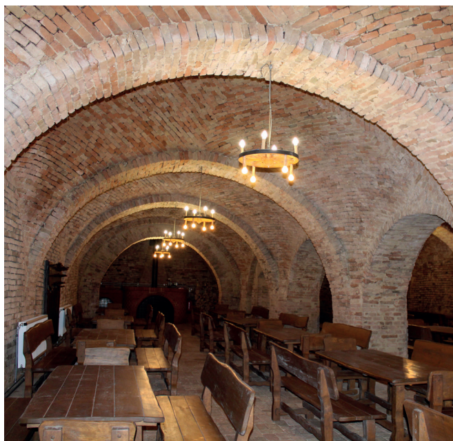
14. ÁBRA: Zichy Pince, Csókakő, csehsüveg boltozatos tér
