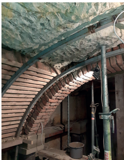
3. ÁBRA: Pinceépítés bányász technológiával [2]
