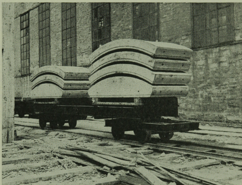
12. ábra. Előregyártott alagútfalazó elemek illesztéseinek szigetelése duzzadó cementtel
