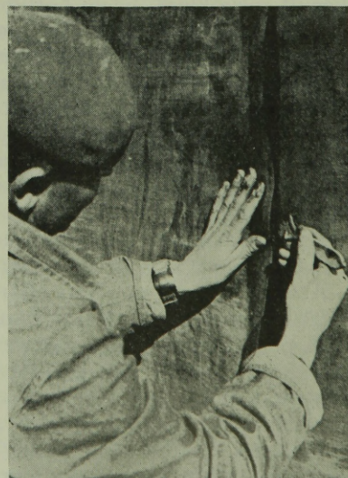
4. ábra. Műanyaglemezzel készülő víznyomás elleni szigetelés, az átfedés összeragasztása duzzadóragasztással (RHEPANOL-BA lemez)
