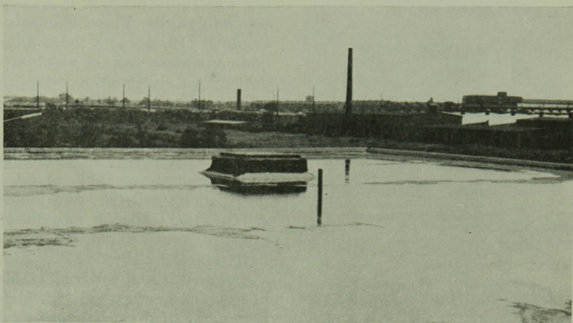
18. ábra. Műanyaglemezrel készült lejtésmentes tető, esőzés után (RHEPANOL-BA lemez)
