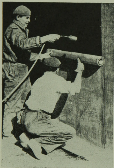
1. ábra. Műanyag szigetelőlemez felragasztása függőleges falra, víznyomás elleni szigetelés készítésénél (RHEPANOL-BA lemez)
