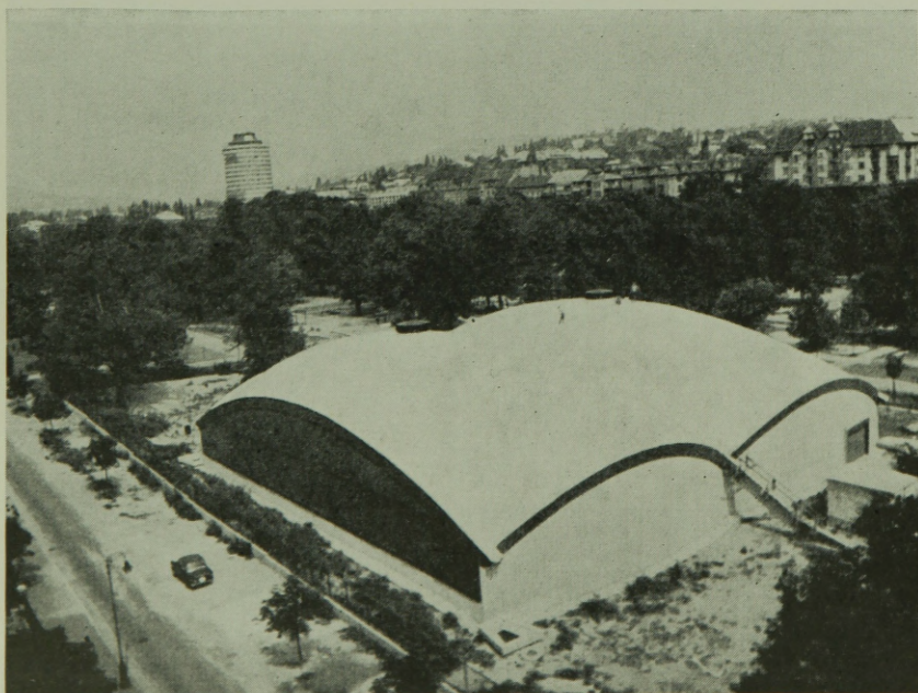
22. ábra. Vasbeton héjszerkezet ELASTOLEN műanyagmáz fedéssel munka közben. A hég alakjánál fogva is tipikusan mázas fedésre alkalmas (VTSK-Teniszcarnok, Városmajor)
