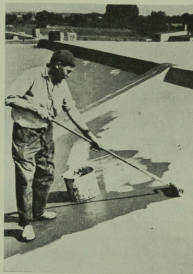
23. ábra. ELASTOLEN műanyagmáz felhordása műanyag hengerrel (Békéscsaba, Konzervgyár)
