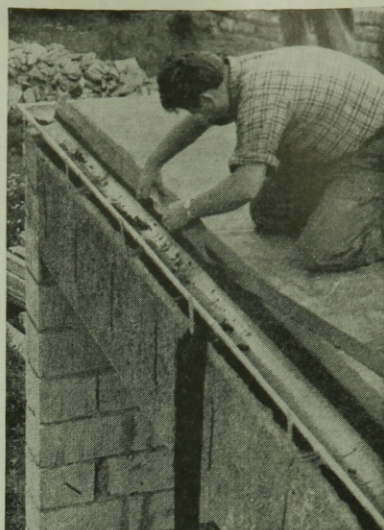
16. ábra. Műanyaglemez fedés bádogosmunkával kombináltan. A képen jól látható, hogy a fedés végződése takarószalaggal csatlakozik a függőeresz-csatornához (PREWANOL lemezfedés)
