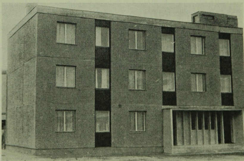
3. ábra. A békéscsabai kísérleti lakóépület bejárati homlokzata
