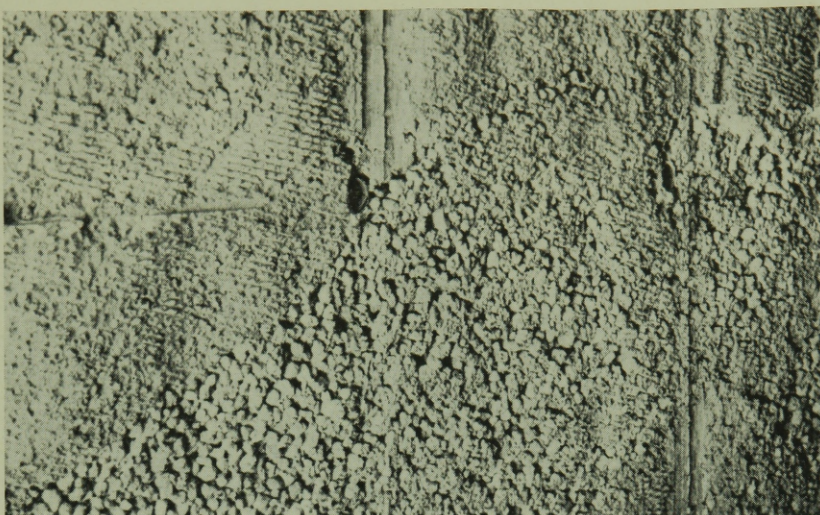
4. ábra. Öntött kohó-habsalak falszerkezet adalékanyag differenciálódása helytelen bedolgozás következtében
