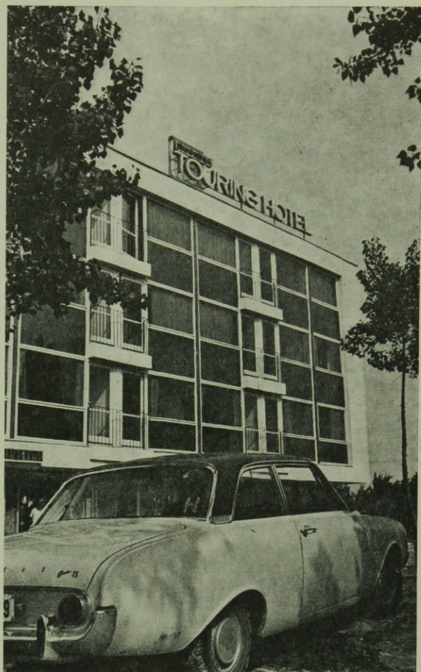
8. kép. B. Szántód, Turing Hotel külső felületképzése fehér színben, gépi szórt kivitelben
