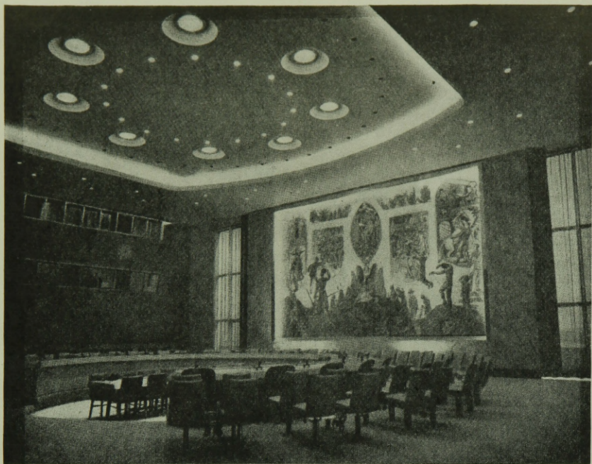
44. ábra. Diplomata tárgyalóterem álmennyezetbe szerelt világító- rendszere krokodilfelületű lámpatestekkel
