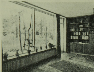
12. ábra. Családi ház fixen üvegezett nagyméretű ablaka
