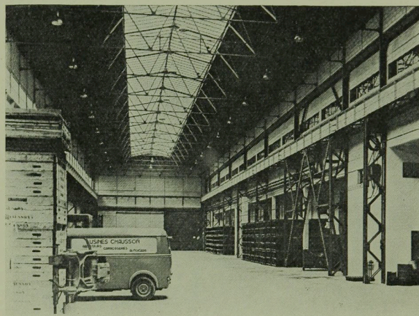
5. ábra. Gerinementi világításáv. (Chausson üzem — Reims, O. T. U. A. foto: H. Lacheroy)
