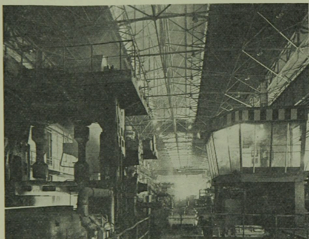
32. ábra. Acélszerkezetű kormánypad a Dunai Vasmű Meleghengerművében
