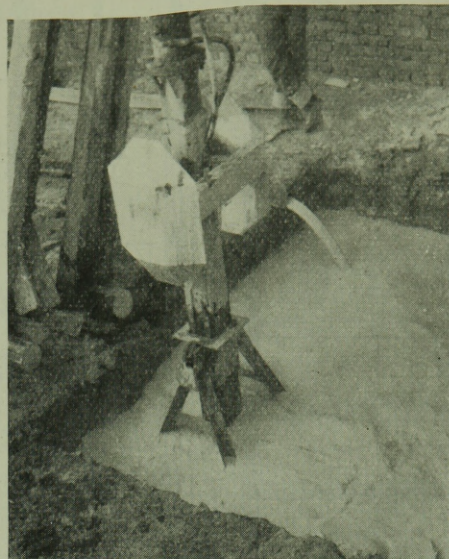
5. fénykép. Résfal-pillér készítése közvetlenül fal mellett a siófoki munkahelyen. (Fotó: Nagy)
