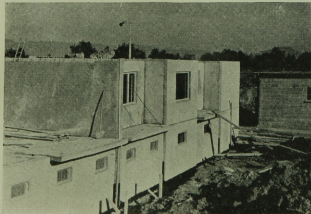
7. ábra. A panelház építés közben
