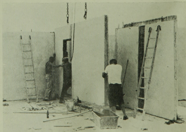
6. ábra. A panel behelyezése
