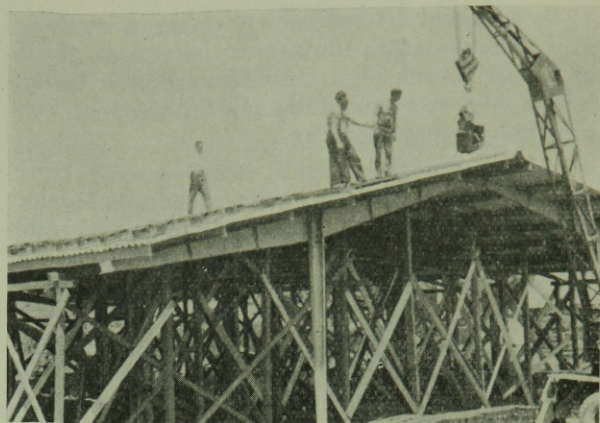
1. ábra. Acélszerkezet próbaterhelése téglával
