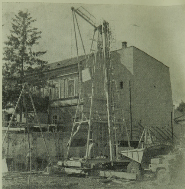
2. fénykép. A TITANIA T-100 markolóval felszerelt réselógép
