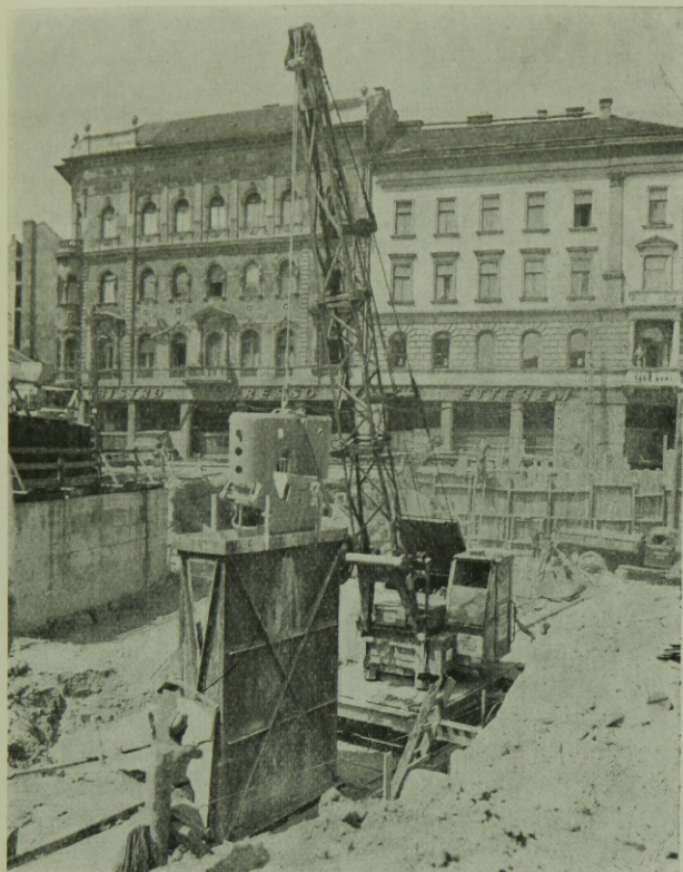
4. fénykép. Hazai gyártású, ICOS-rendszerű réselőgép. (Fotó: dr. Juranics)
